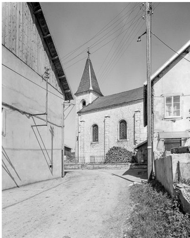
Façade latérale droite.
