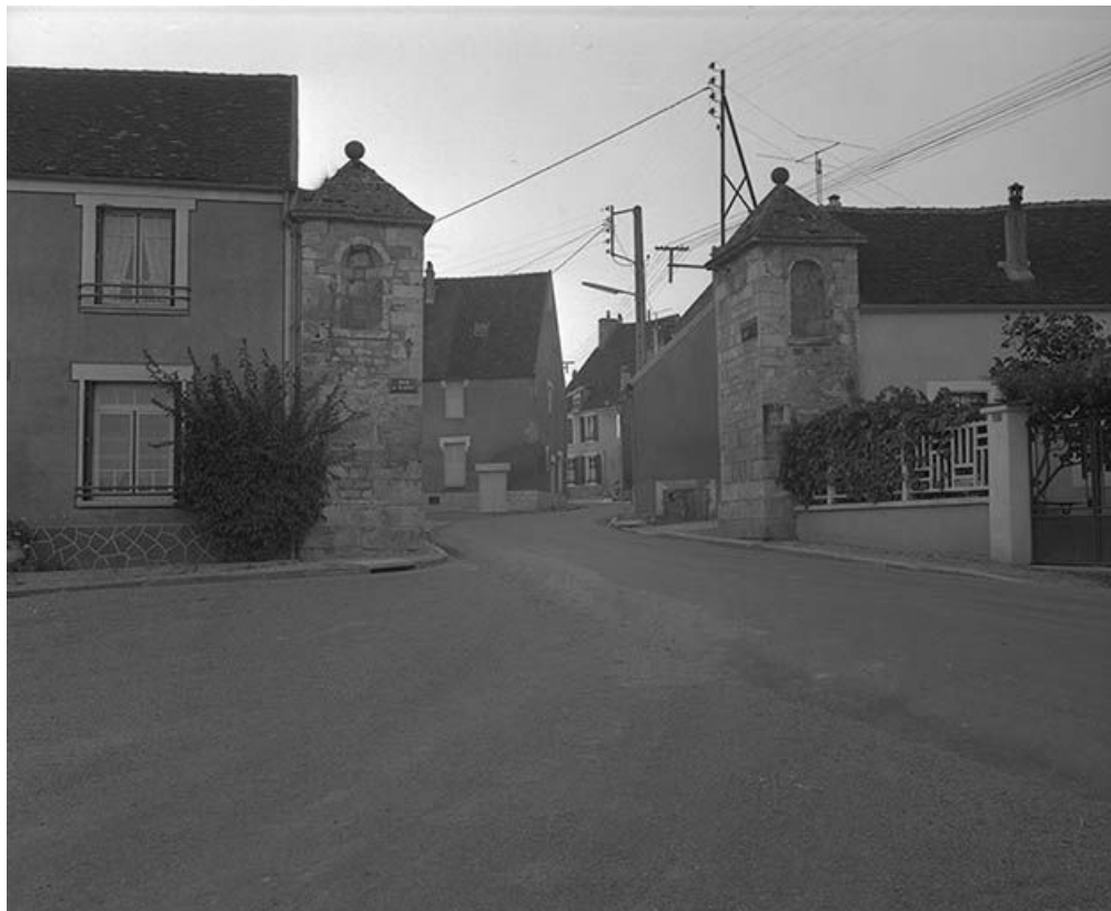
Porte d'Arbault. 89, Cravant
