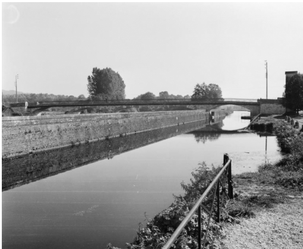
Pont enjambant l'embranchement du canal d'Accolay.
