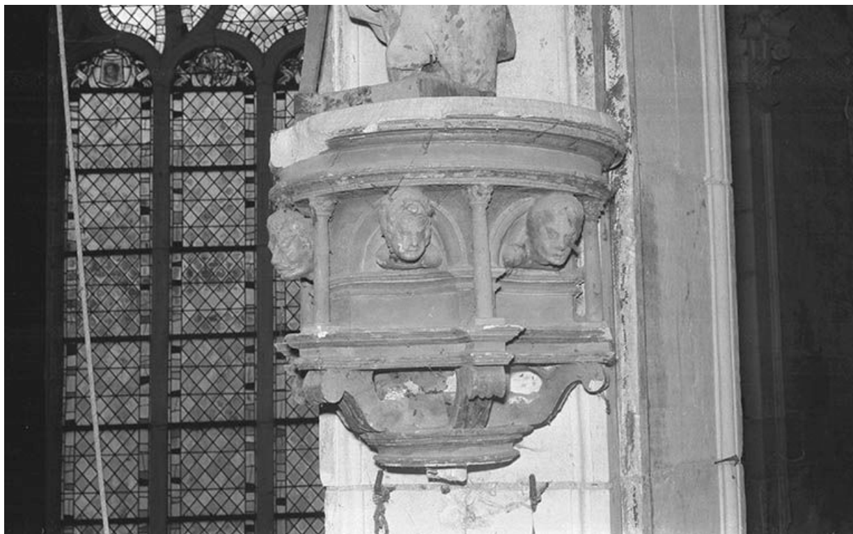
2ème pilier du rond-point, console. 89, Cravant
