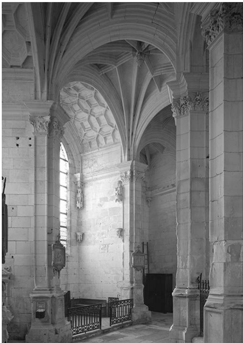
Côté droit du déambulatoire, vue depuis la chapelle axiale.
