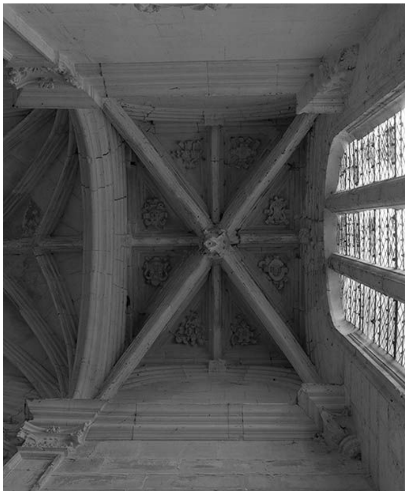
Vue d'ensemble du voûtement d'une des chapelles latérales
