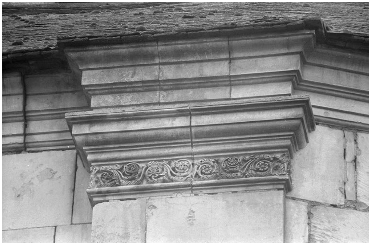
Détail d'un pilastre du chevet.
