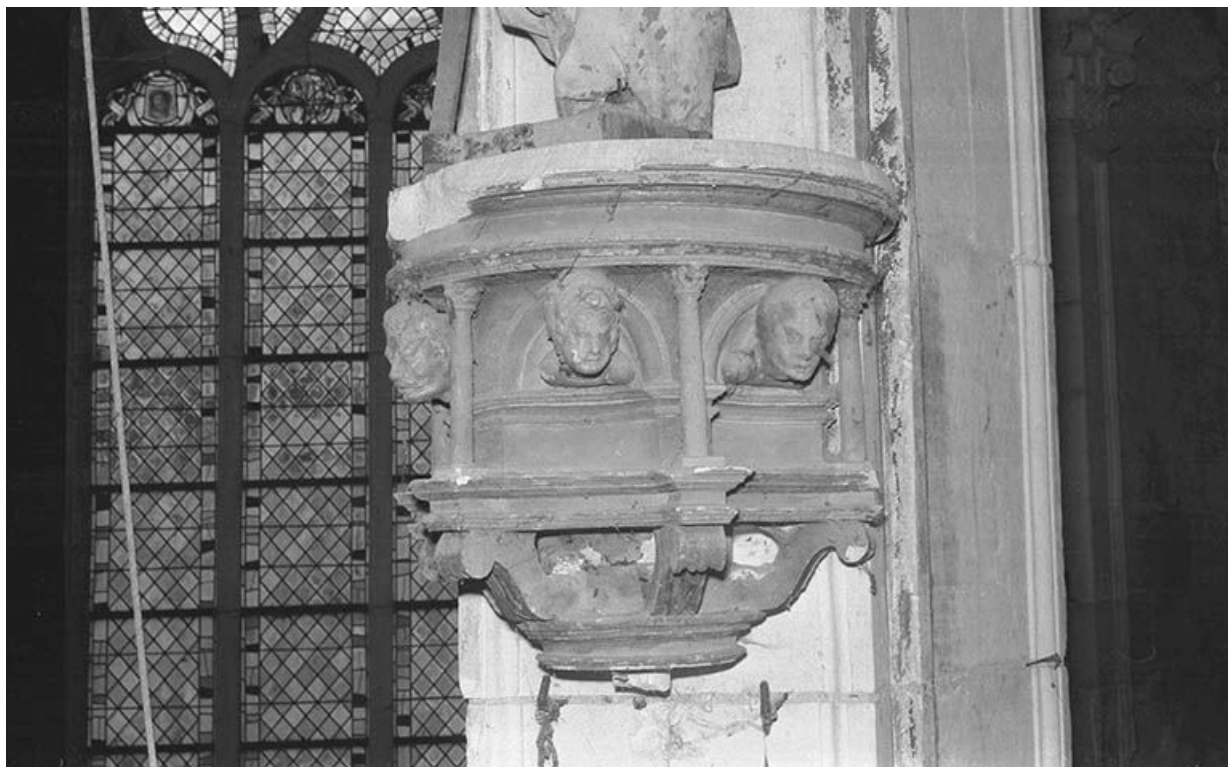
2ème pilier du rond-point, console. 89, Cravant
