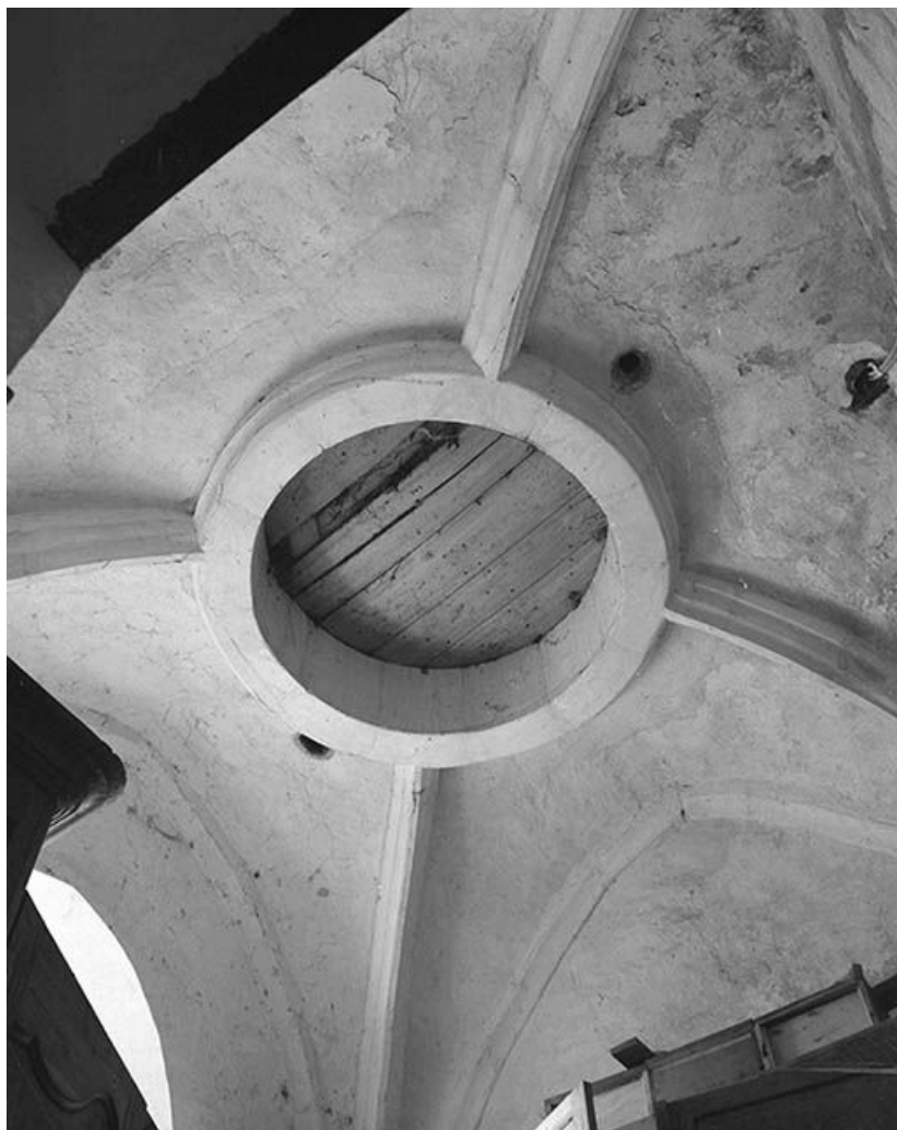
Clocher, niveau inférieur : voûte.
