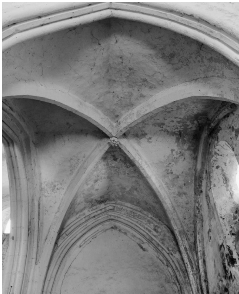
Collatéral gauche, 2è travée : voûtement.
