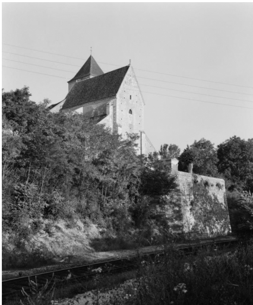
Vue d'ensemble, prise du canal.
