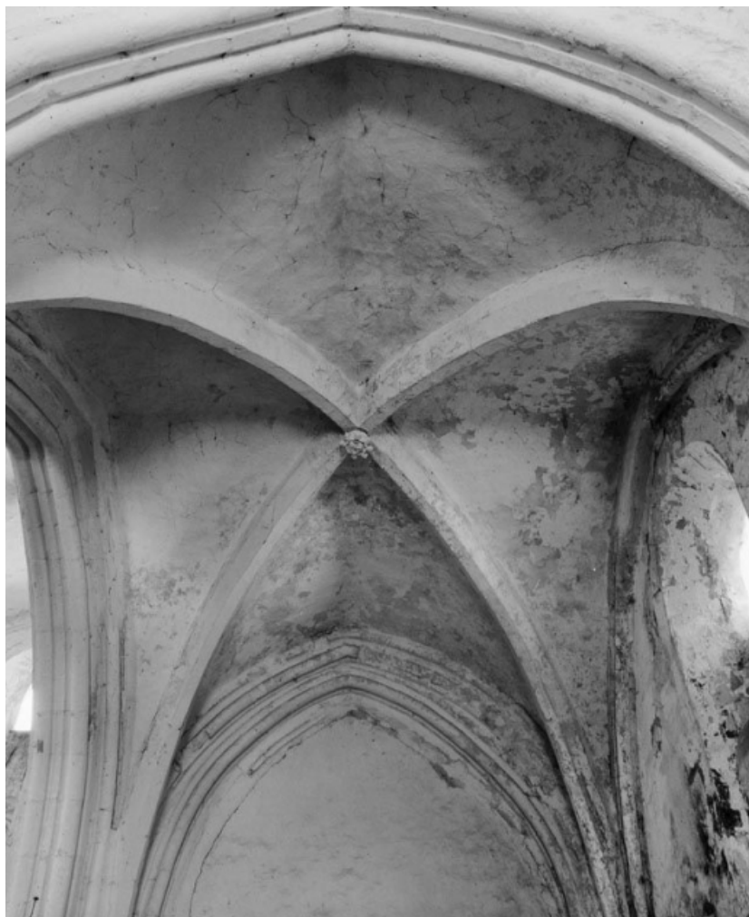
Collatéral gauche, 2è travée : voûtement.
