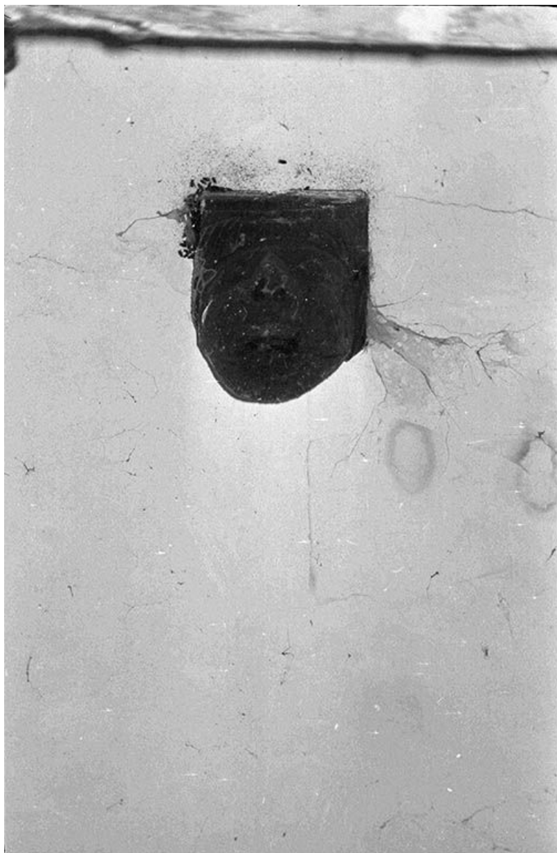
Choeur, extrémité sculptée d'un poinçon pendant de la charpente. 89, Sainte-Pallaye
