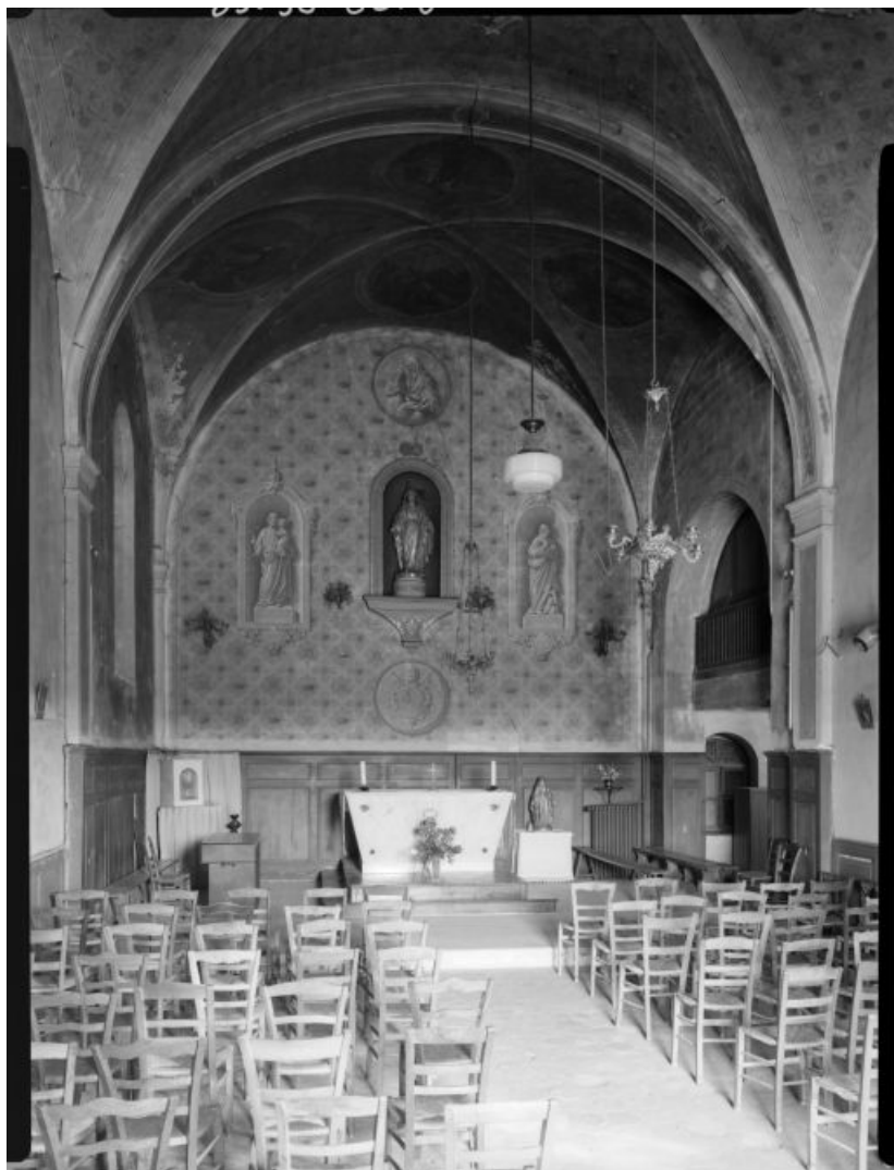
Vue intérieure de la chapelle.
