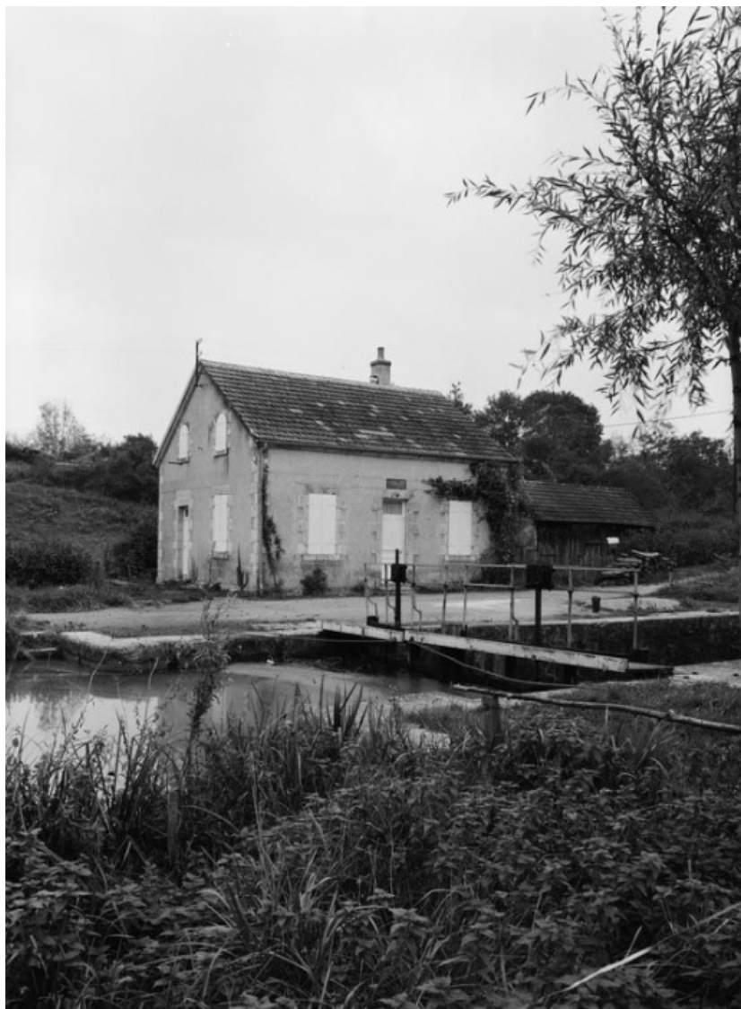
La maison éclusière vue d'amont.
