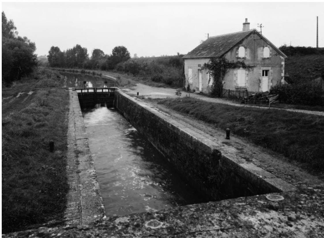
Le sas d'écluse et la maison éclusière à gauche.
