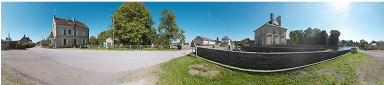
Panoramique avec de gauche à droite : la maison éclusière, le site d'écluse, le pont sur écluse et la maison des ingénieurs. 58, Bazolles, lieudit : bief 01 du versant Loire
