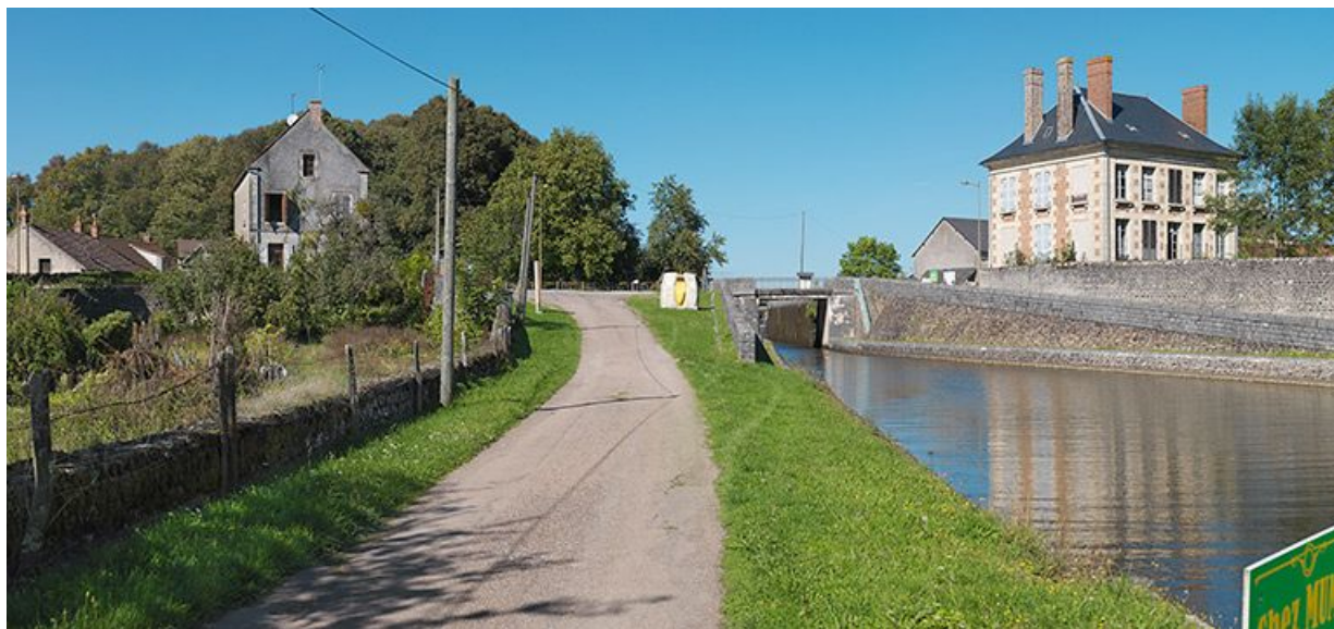
Vue d'ensemble : à gauche la maison éclésièrre (01L) et à droite la maison des ingénieurs. 58, Bazolles chemin de halage du canal du Nivernais, lieudit : Baye
