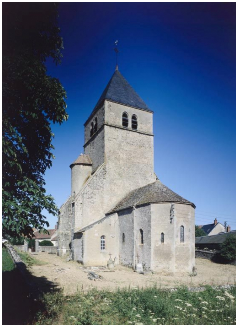
Vue d'ensemble depuis le chevet.
