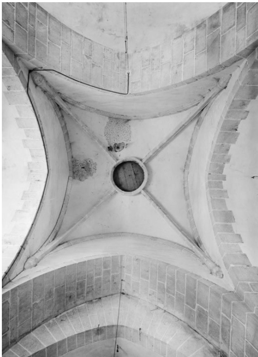
La voûte de la travée sous clocher.
