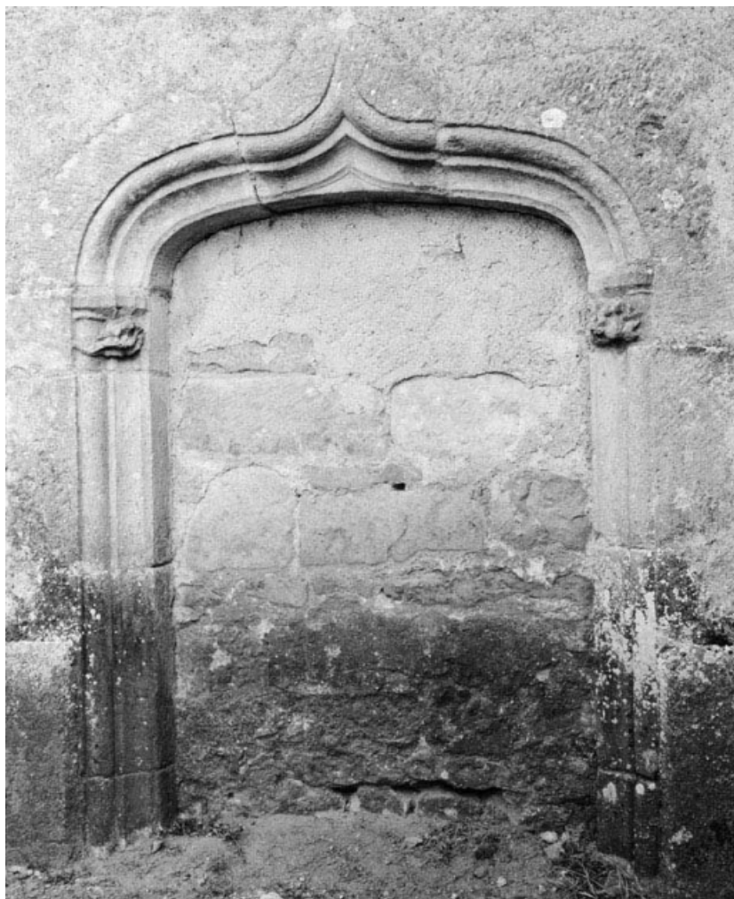
Porte latérale droite murée dans la nef.
