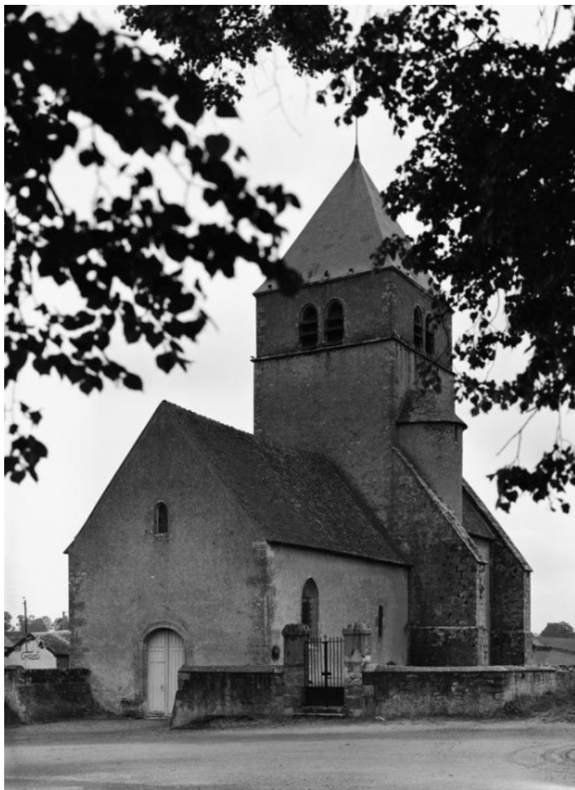
Vue d'ensemble : élévations antérieure et droite.
