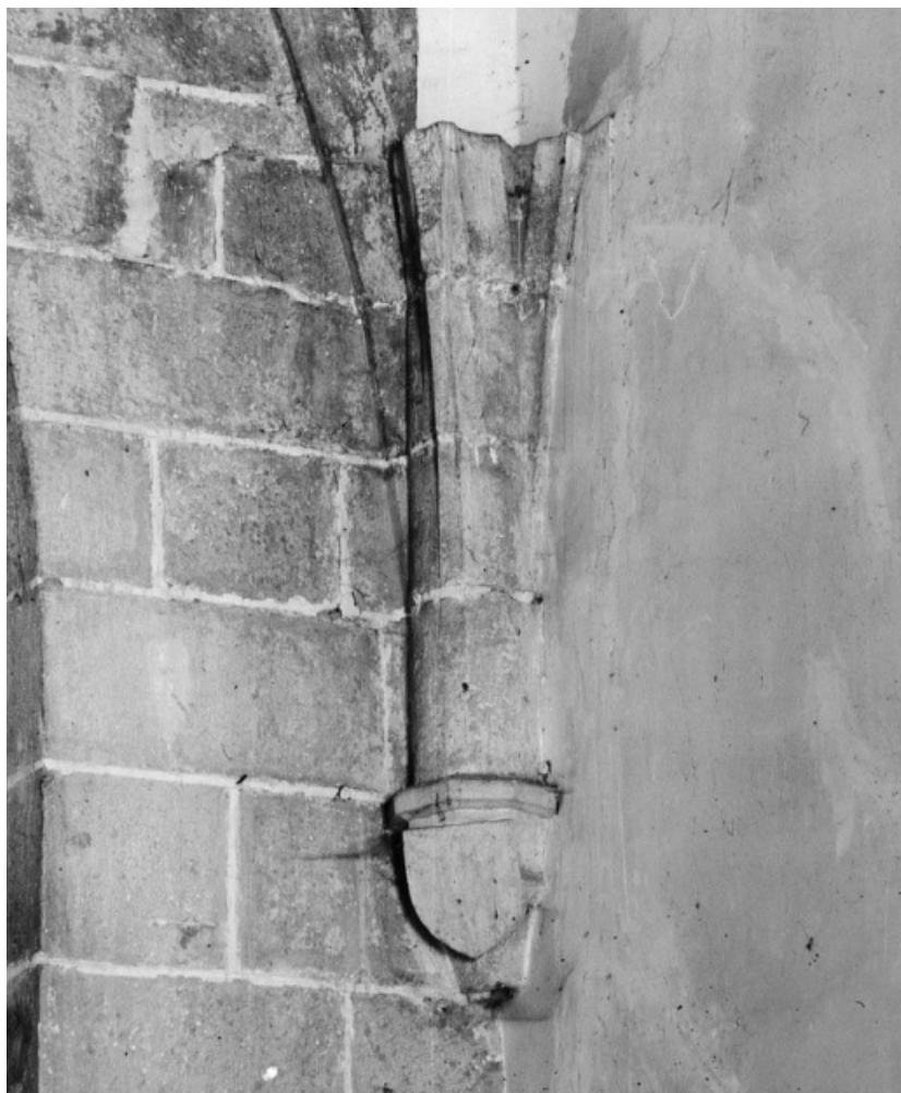
Culot postérieur droit de la nef.
