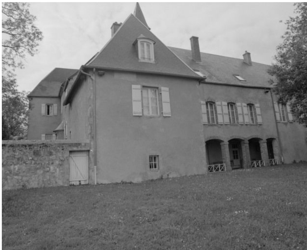
Vue d'ensemble de la façade postérieure.
