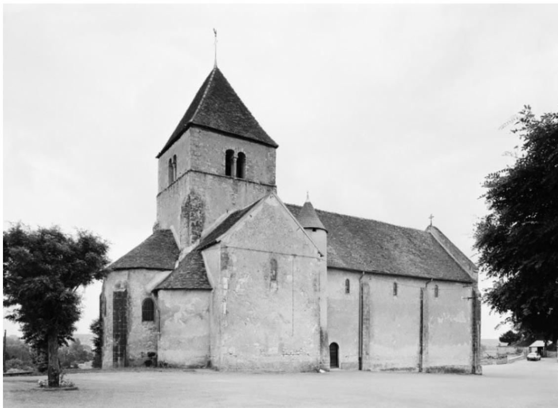
Elévation latérale gauche, vue prise du nord-est.
