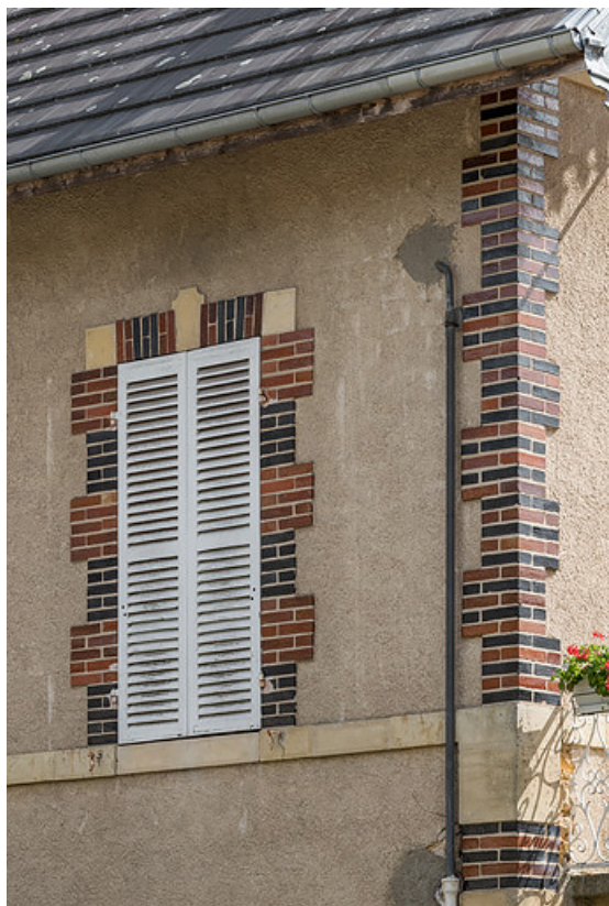
Encadrement de baie et chaîne d'angle harpée en brique vernissée.
