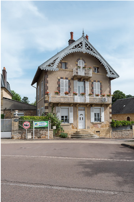
Façade principale sur l'avenue Eugène Collin. 58, Saint-Honoré-les-Bains, 11 avenue Eugène Collin
