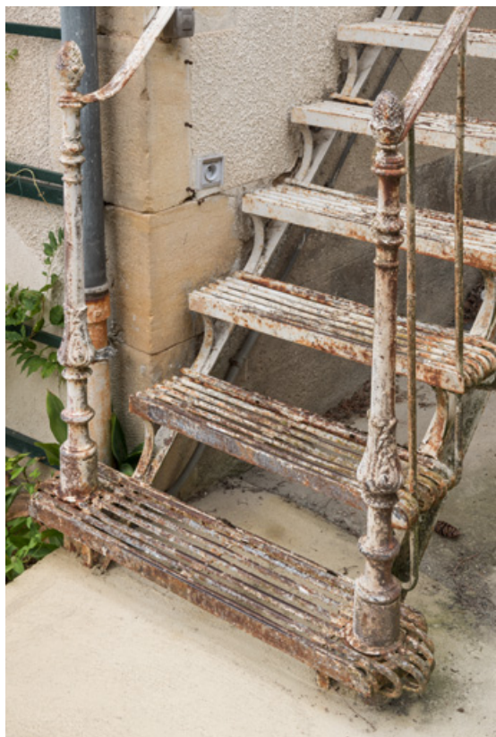
Escalier extérieur conduisant à l'étage, détail.
