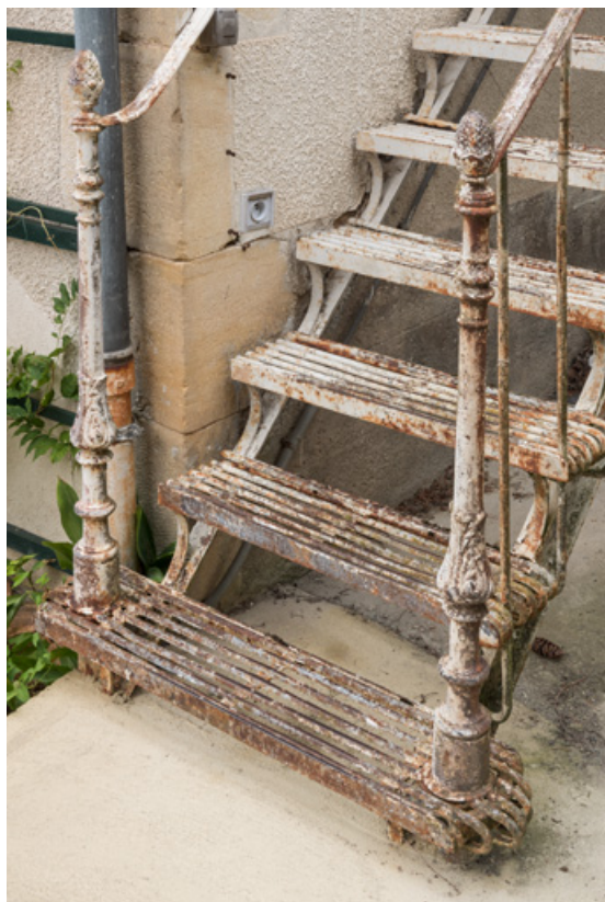
Escalier extérieur conduisant à l'étage, détail.
