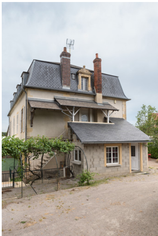
Flanc nord-est avec l'escalier extérieur conduisant à l'étage.
