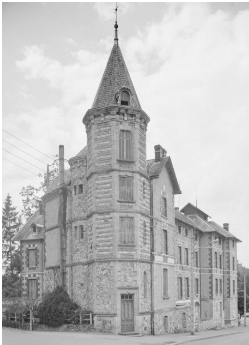
Tour de l'angle sud-ouest, vue d'ensemble en 1978. 58, Saint-Honoré-les-Bains, 1 avenue Jean Mermoz
