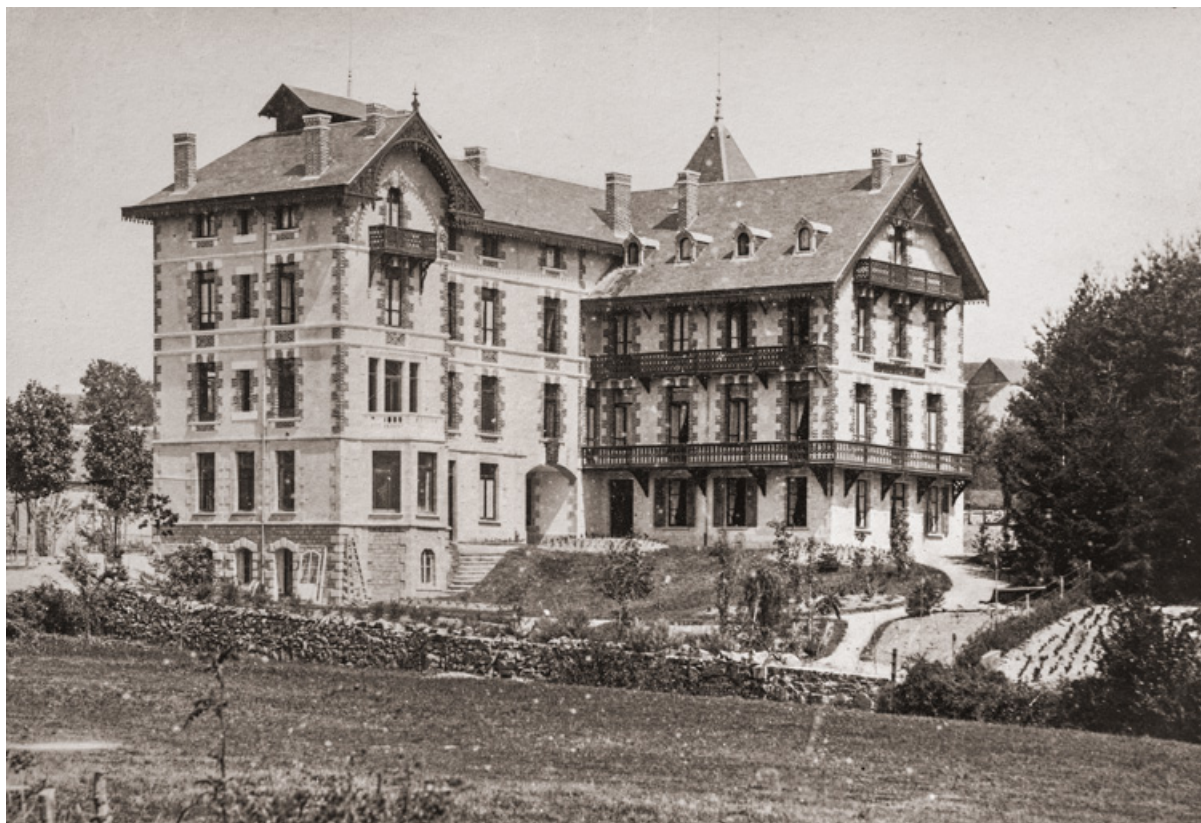
Façade sur le parc avant la destruction des balcons et galeries.
