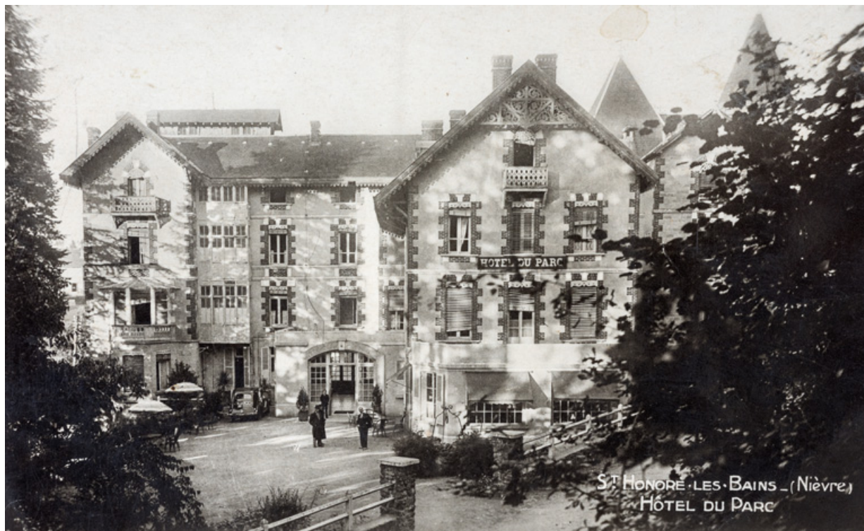
Façade sur le parc après la destruction des balcons et galeries.
