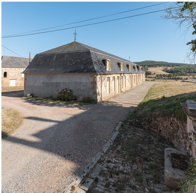
Bâtiment de l'ancienne écurie, vue depuis le nord-ouest.
