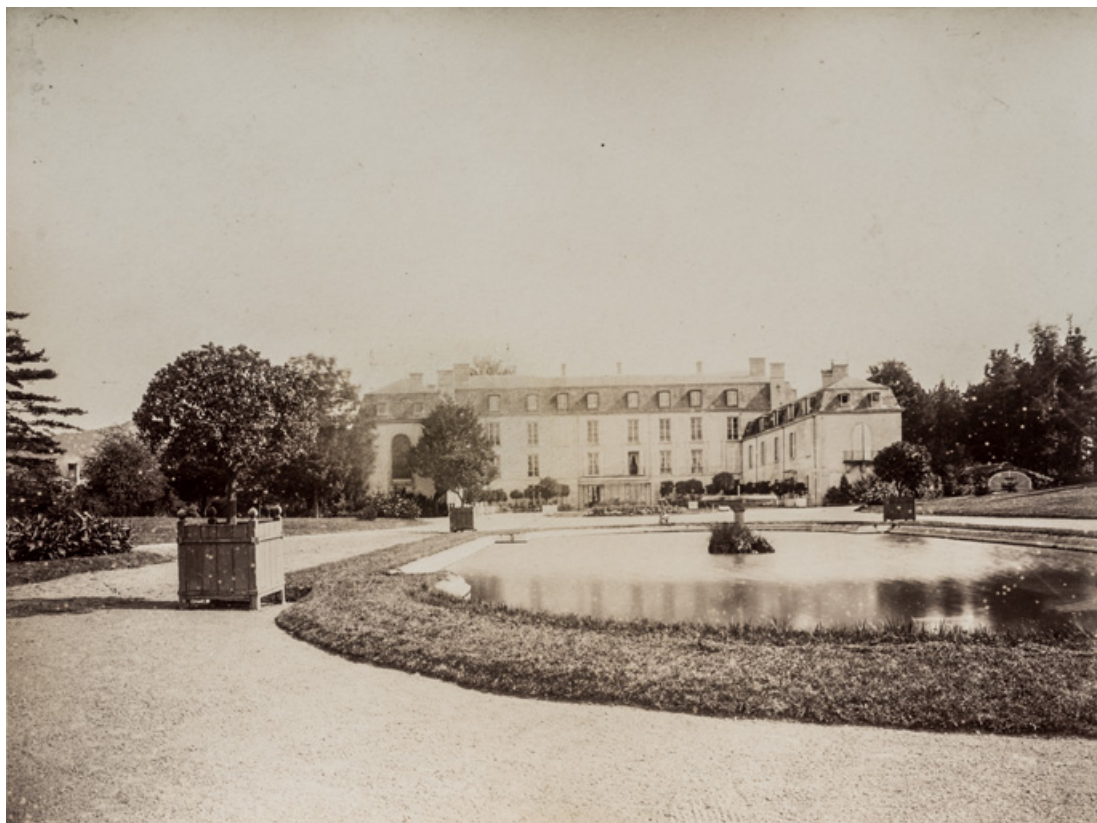
Bassin et vue sur la cour.
