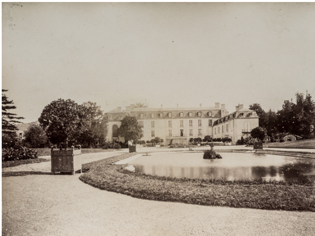
Bassin et vue sur la cour.
