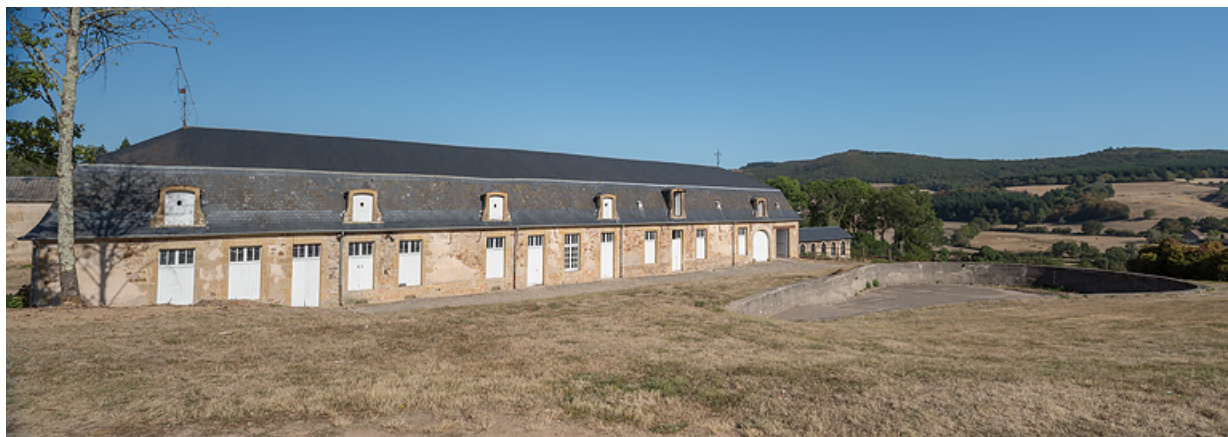
Bâtiment de l'ancienne écurie, vue depuis l'ouest.
