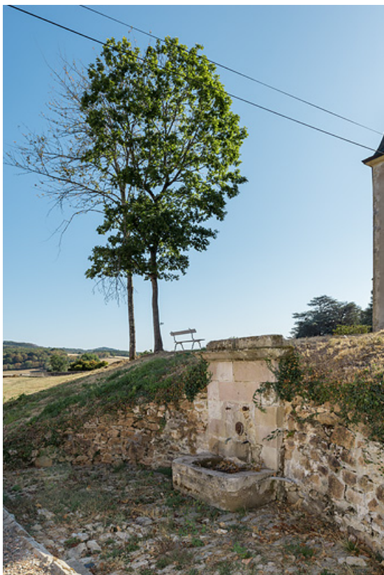
Fontaine-abreuvoir à proximité de l'écurie.
