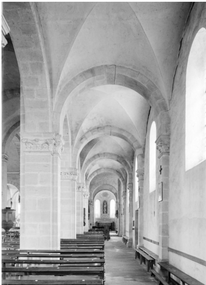
Bas-côté droit : vue d'ensemble depuis les fonts baptismaux.
