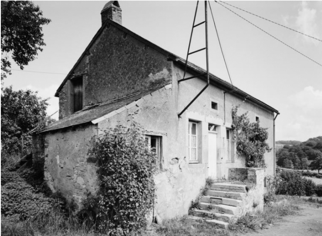
Détail de l'escalier du logis.
