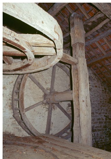
La roue de presse et la roue à écureuil. Phot. Jean-Luc Duthu IVR26_20028900403ZA
