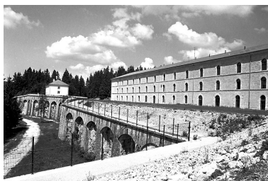
Enceinte du fort. Phot. Jérôme Mongreville IVR43_20003900213X
