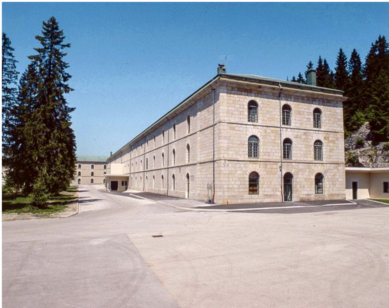
Bâtiment Quitry, façade antérieure et face droite.
