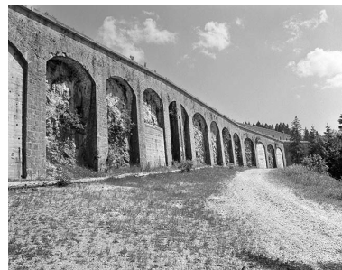
Enceinte du fort. Phot. Jérôme Mongreville IVR43_20003900190X
