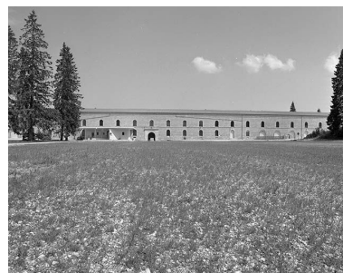
Bâtiment Cavalier, façade sur la cour d'exercice. Phot. Jérôme Mongreville IVR43_20003900218X
