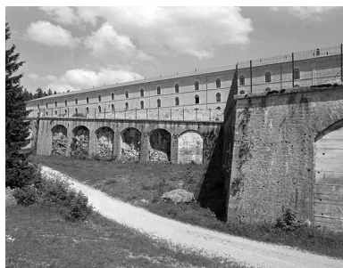
Enceinte du fort, système bastionné. Phot. Jérôme Mongreville IVR43_20003900189X
