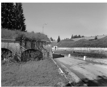
Voie d'accès au fort et fortifications avancées. Phot. Jérôme Mongreville IVR43_20003900215X
