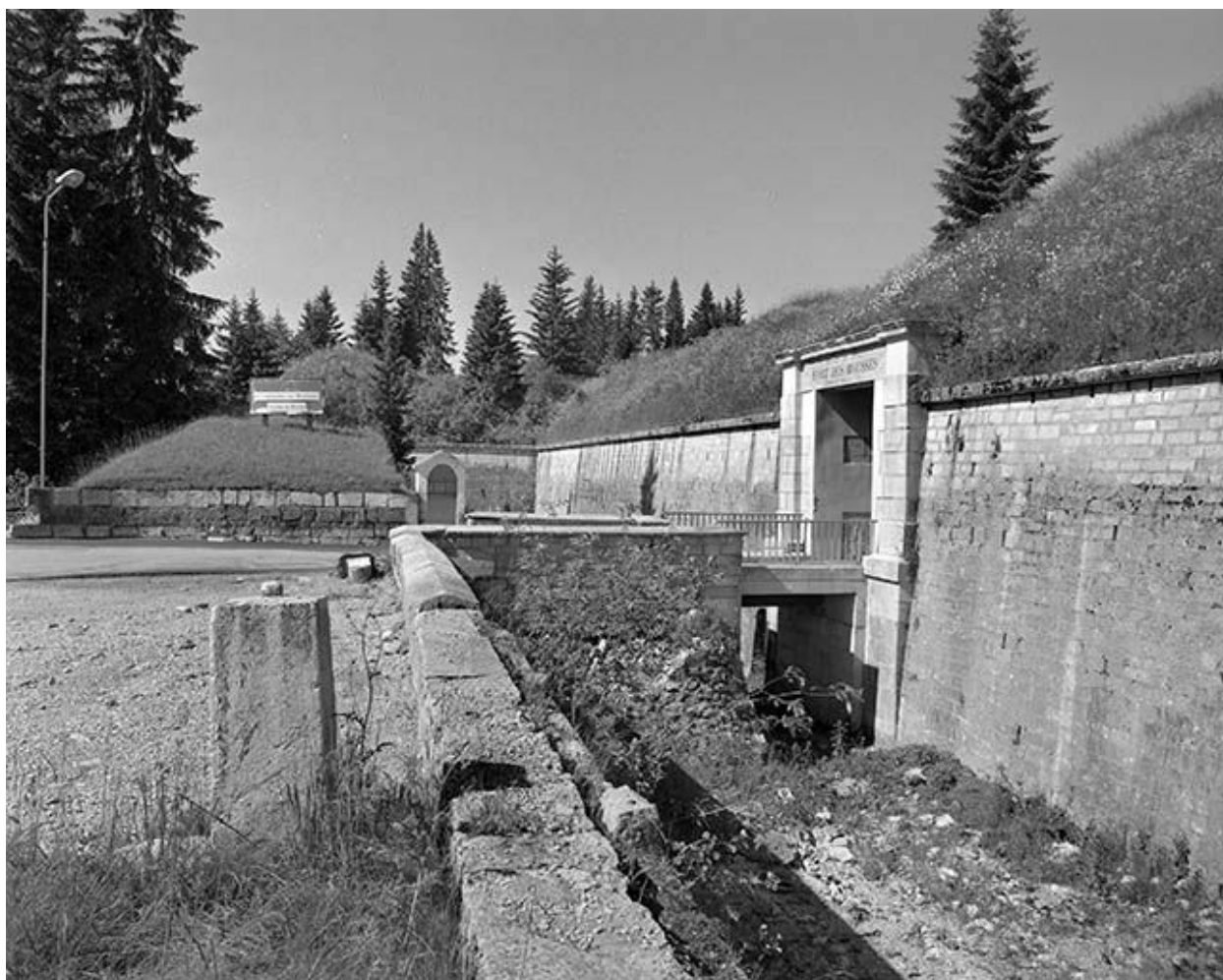
Porche d'accès au fort, fossé.
