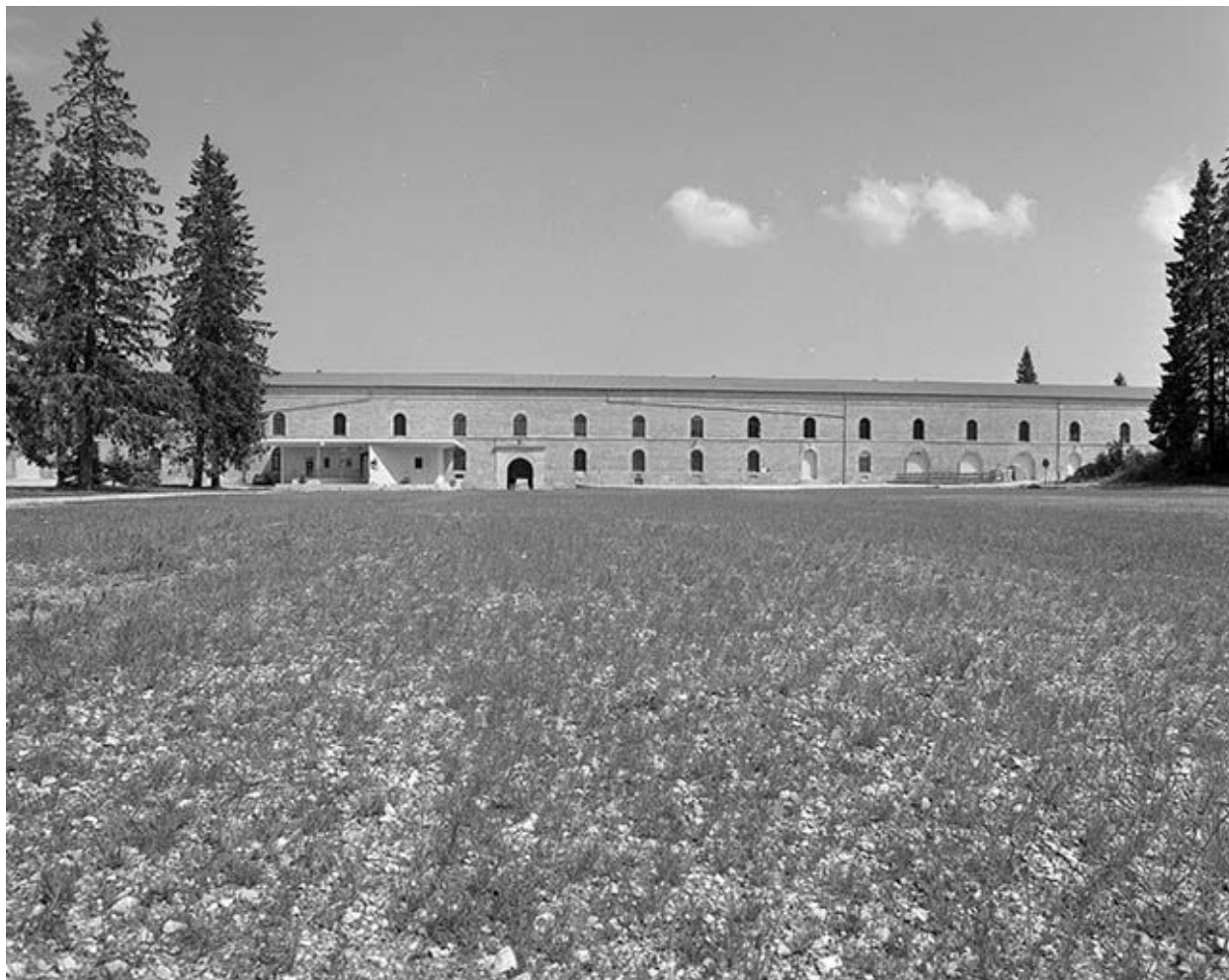
Bâtiment Cavalier, façade sur la cour d'exercice.
