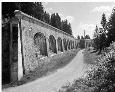
Enceinte du fort. Phot. Jérôme Mongreville IVR43_20003900191X
