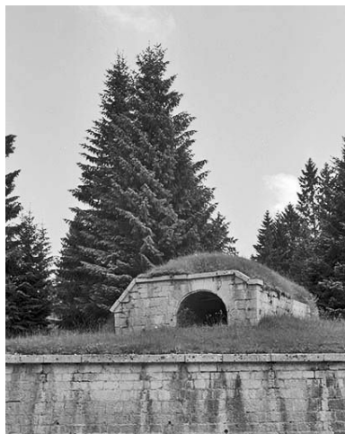
Ouvrage avancé face au porche d'accès. Phot. Jérôme Mongreville IVR43_20003900217X
