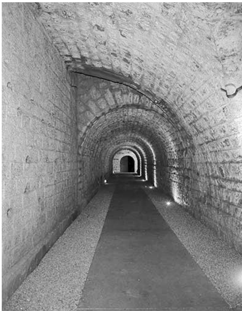
Galerie de circulation à l'intérieur du fort.
