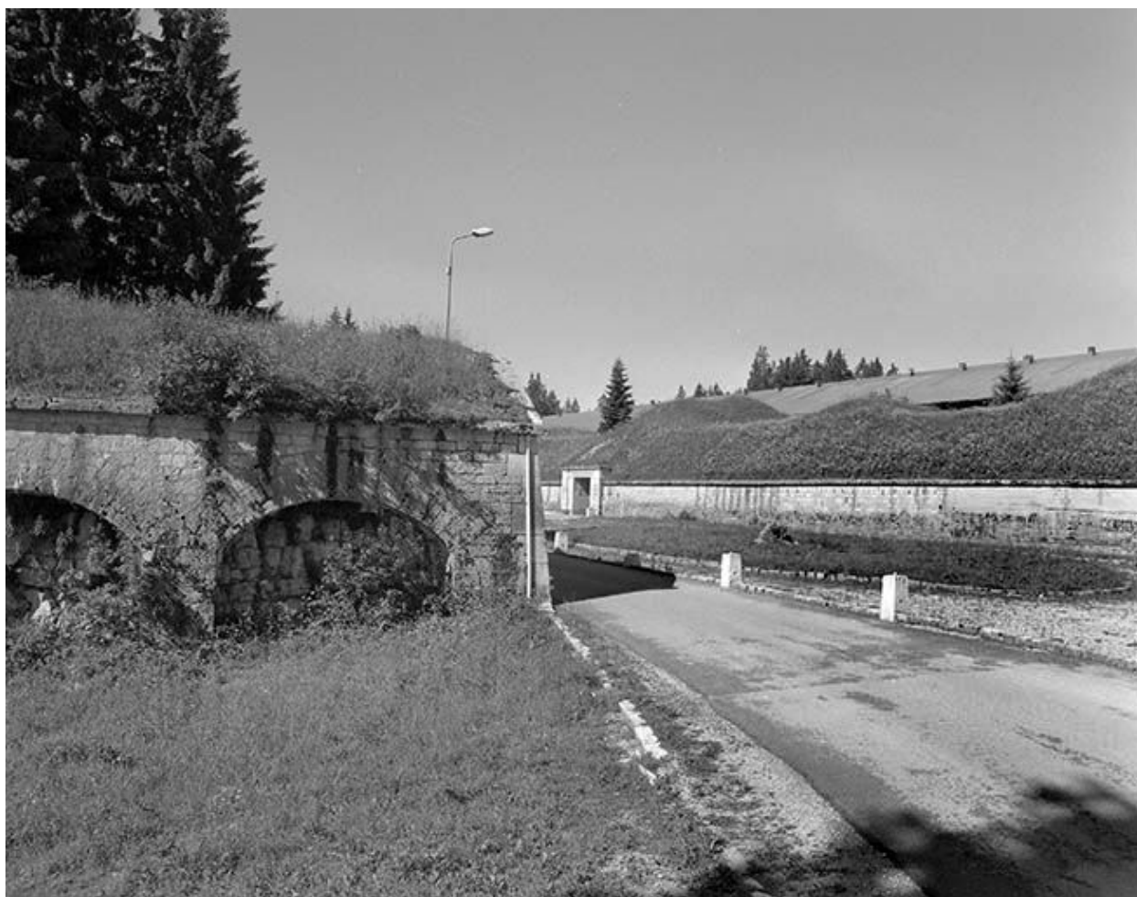
Voie d'accès au fort et fortifications avancées.
