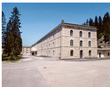
Bâtiment Quitry, façade antérieure et face droite.
