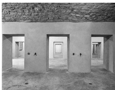
Bâtiment Quitry, pièces successives couvertes de voûtes en berceau segmentaire. Phot. Jérôme Mongreville IVR43_20003900195X
