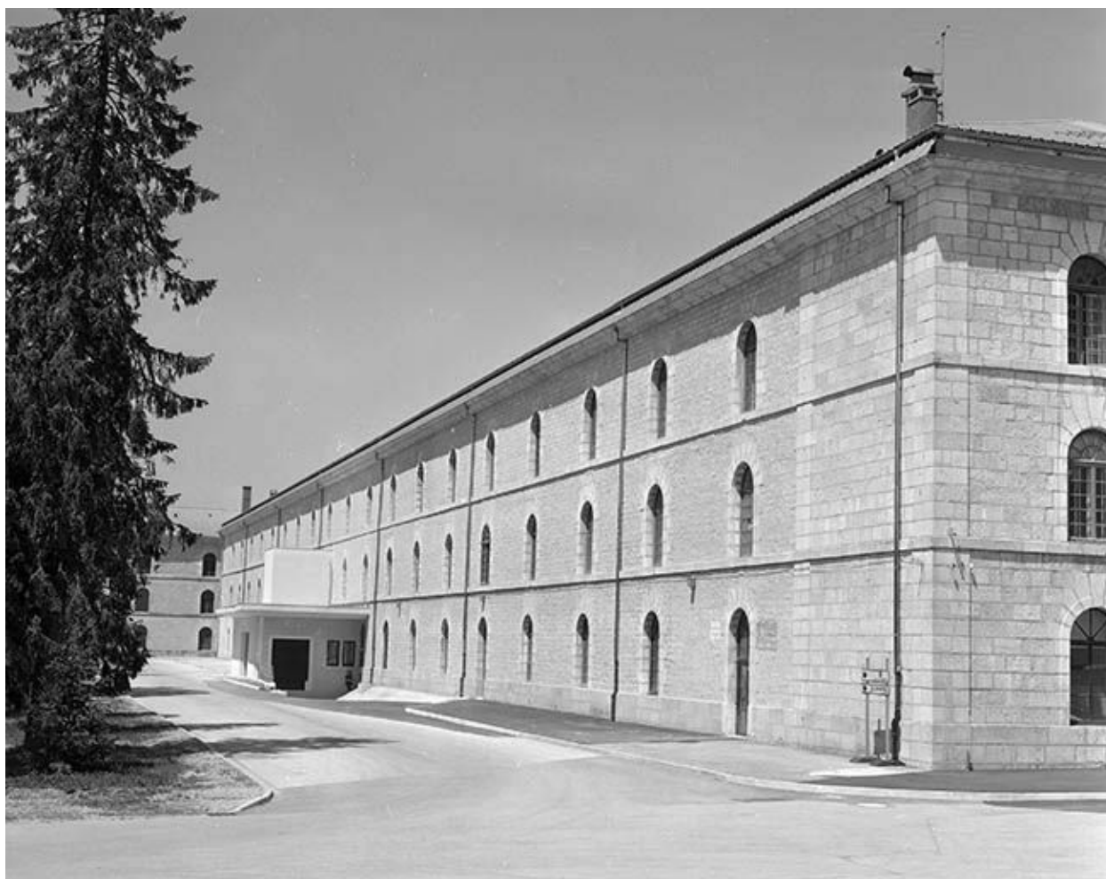
Bâtiment Quitry, façade sur la cour d'exercice.
