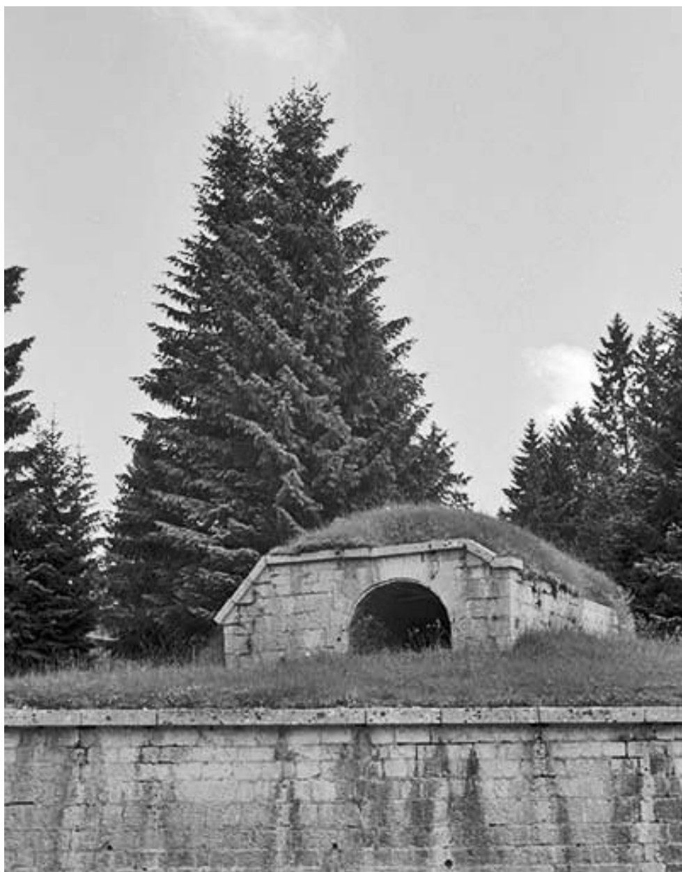
Ouvrage avancé face au porche d'accès.
