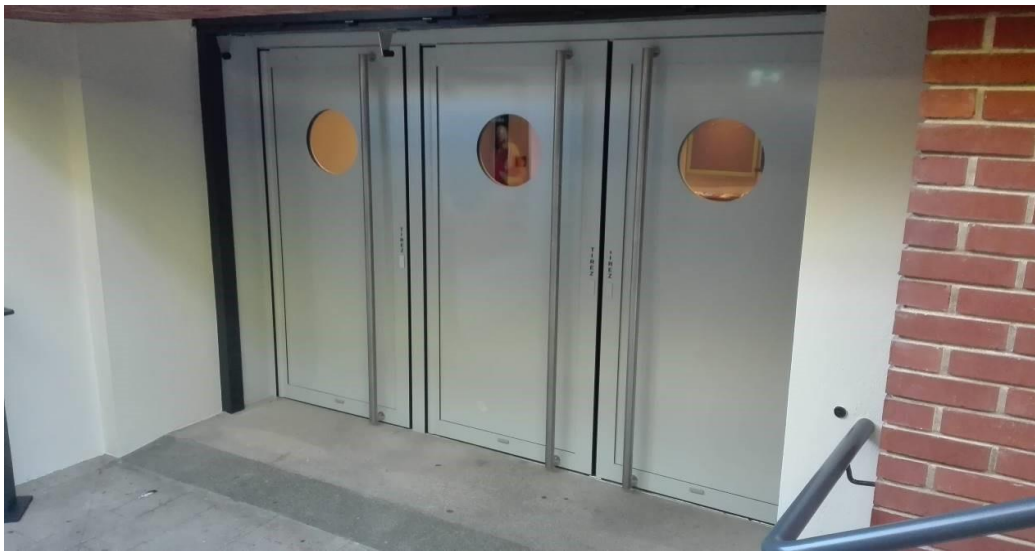
Diagonale entre 2 portes : 2.70m Accès par l'extérieur – escaliers
