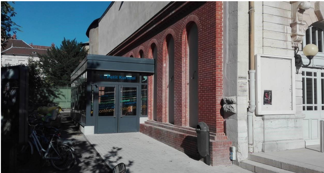
Largeur de passage : 1.80m Hauteur : 2.30m Accès par l'extérieur – parking
