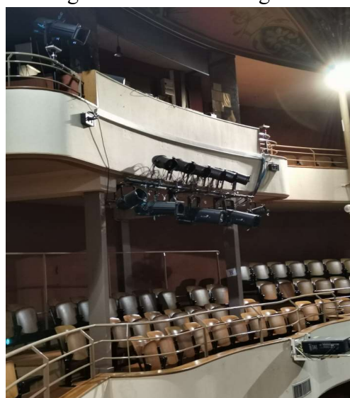
Eclairage face direct sous régie fermée
