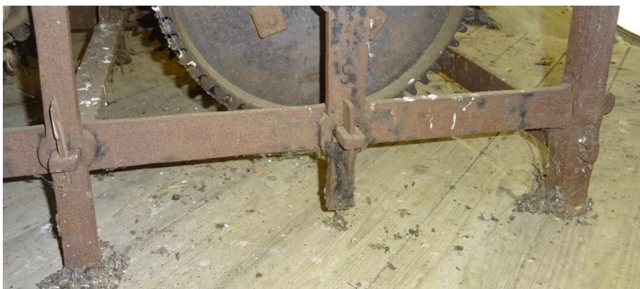
La clavette située sous le S est encore en place, celle de droite est manquante, celle de gauche en bois.
