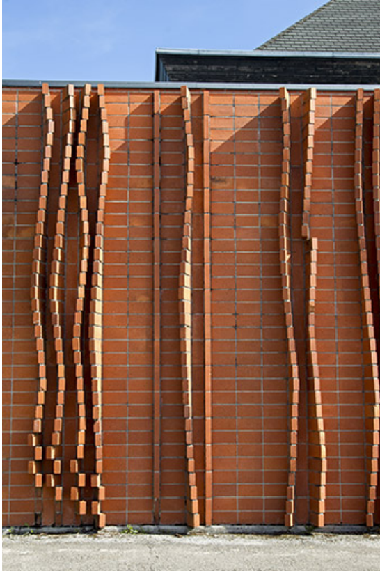
Détail du mur sud.
