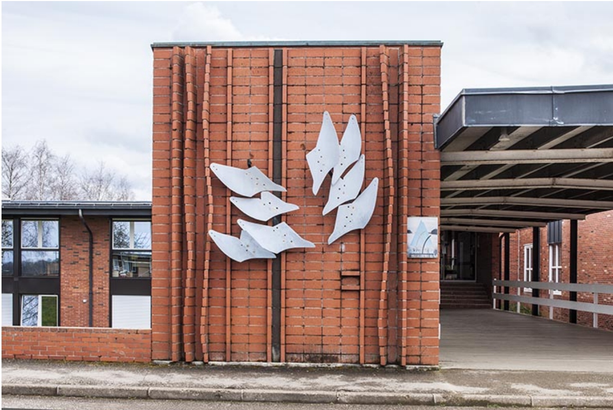
Mur nord vu de face.
