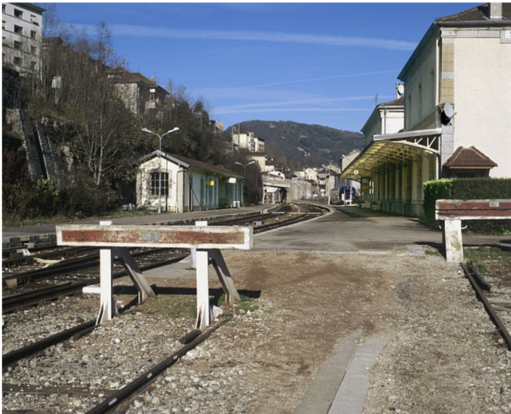
Vue d'ensemble des butoirs.
