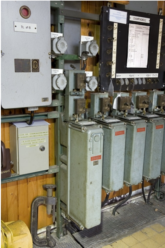
Commutateurs et boutons poussoirs de commande manuelle des passages à niveau.
