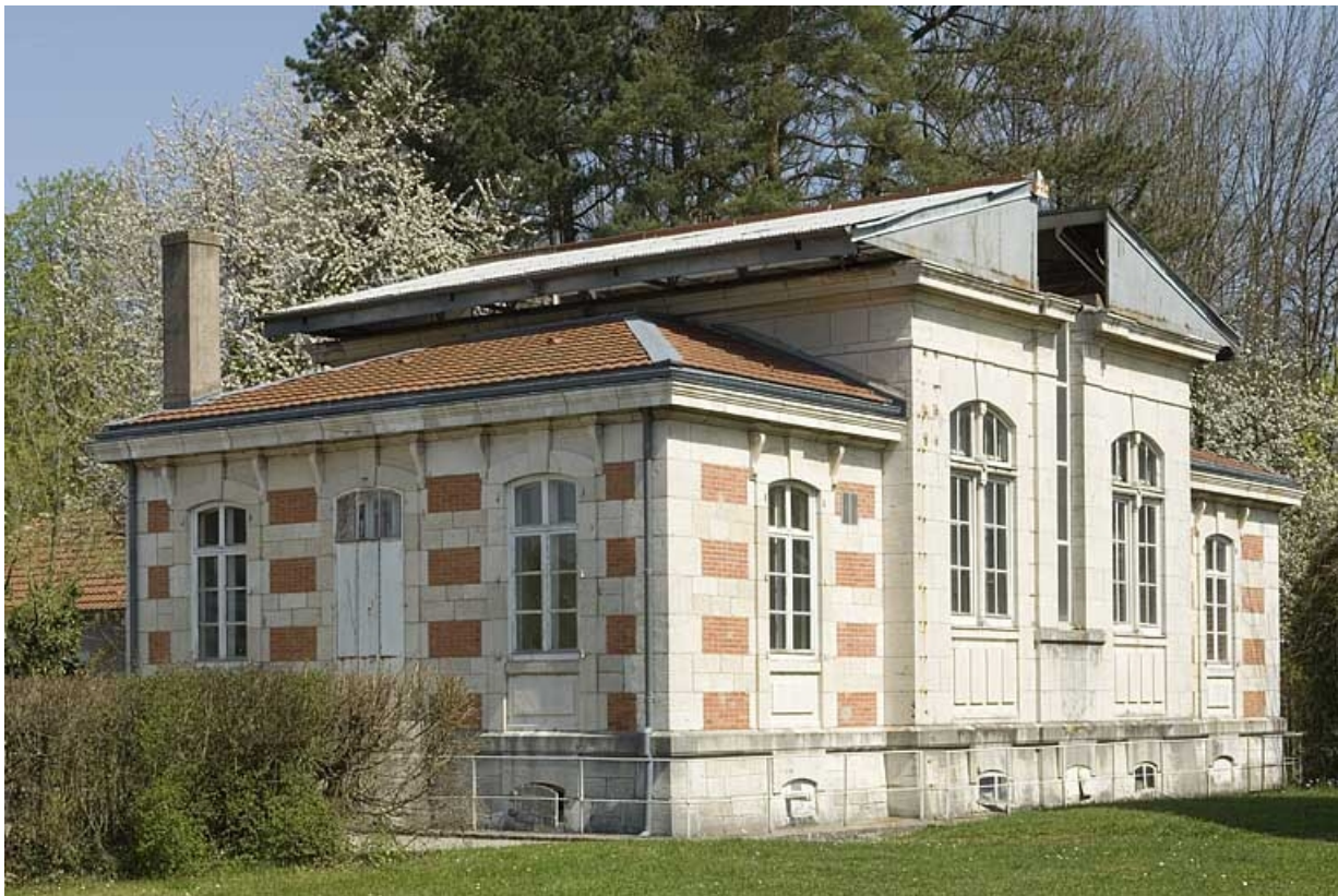
Pavillon de la méridienne, toiture ouverte.
