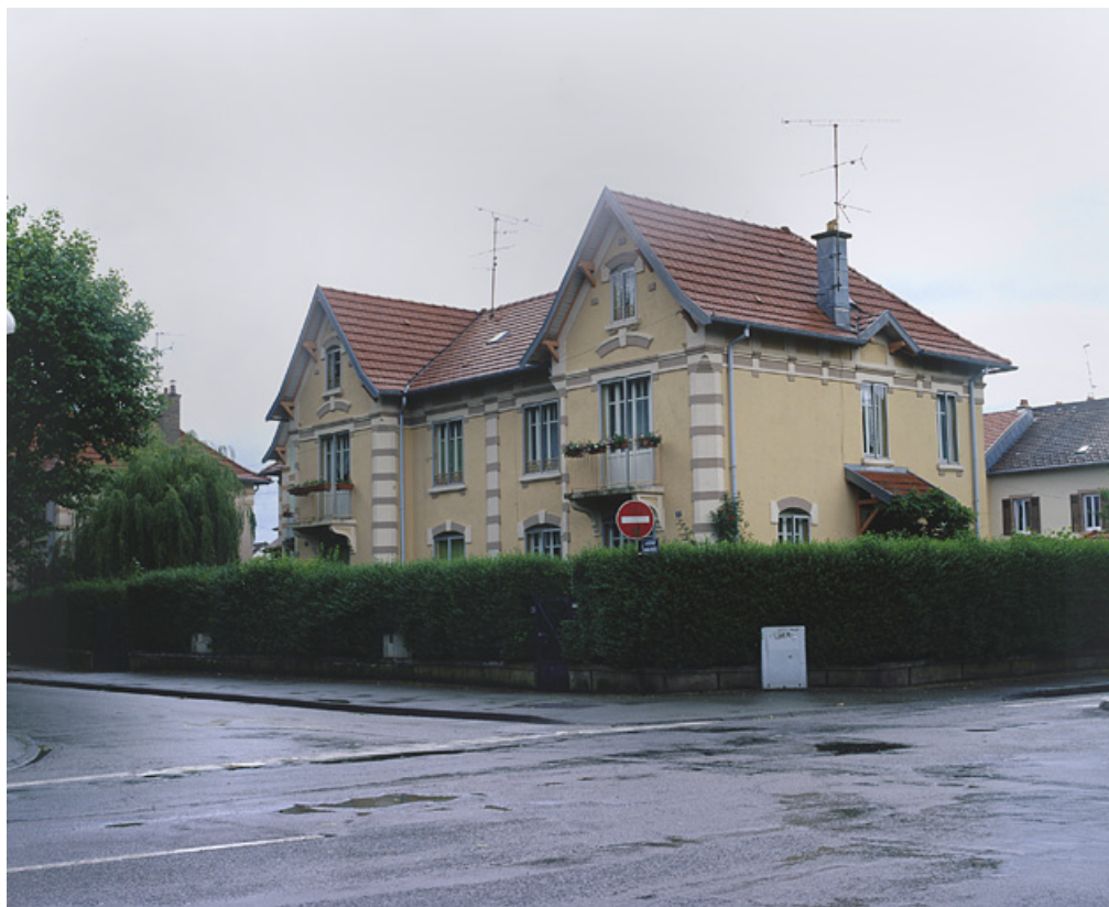
Logement double de contremaître rue d'Alsace.
