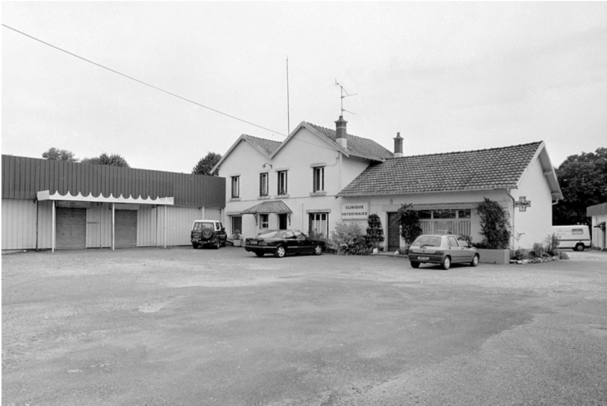
Façade des bureaux (?).
