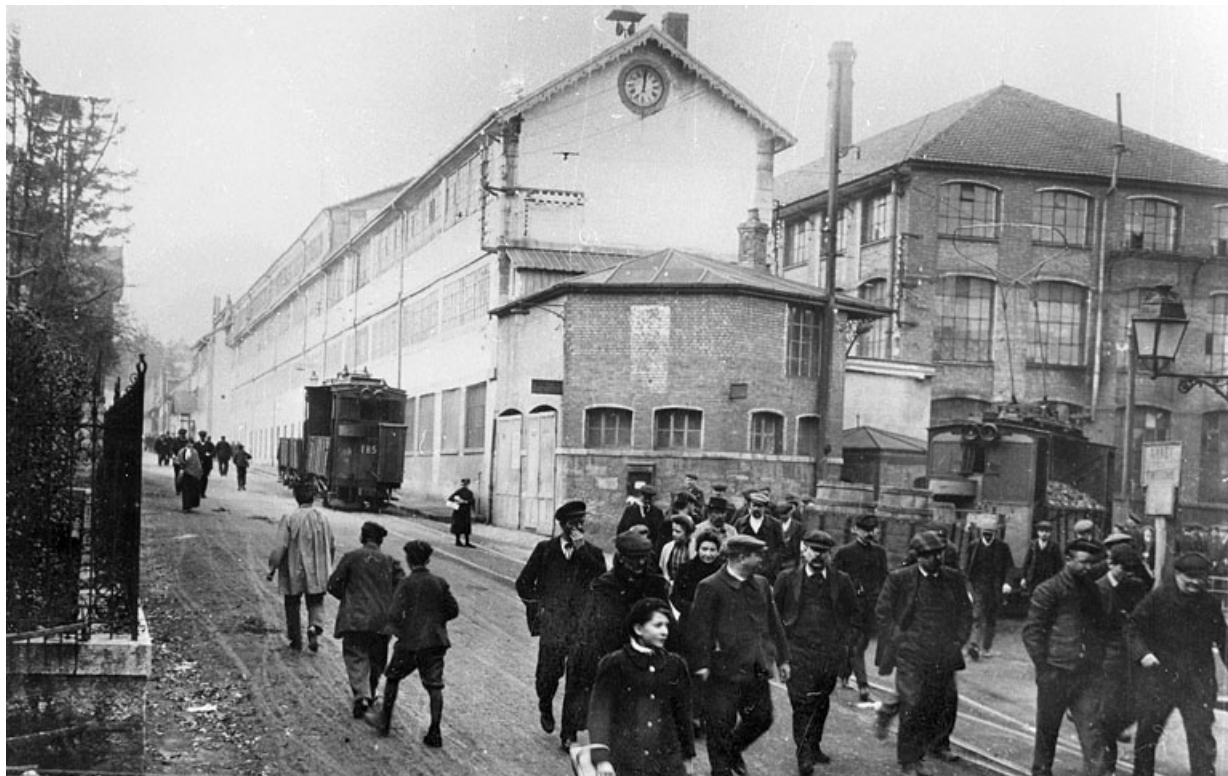
L'usine des Fonteneilles.
