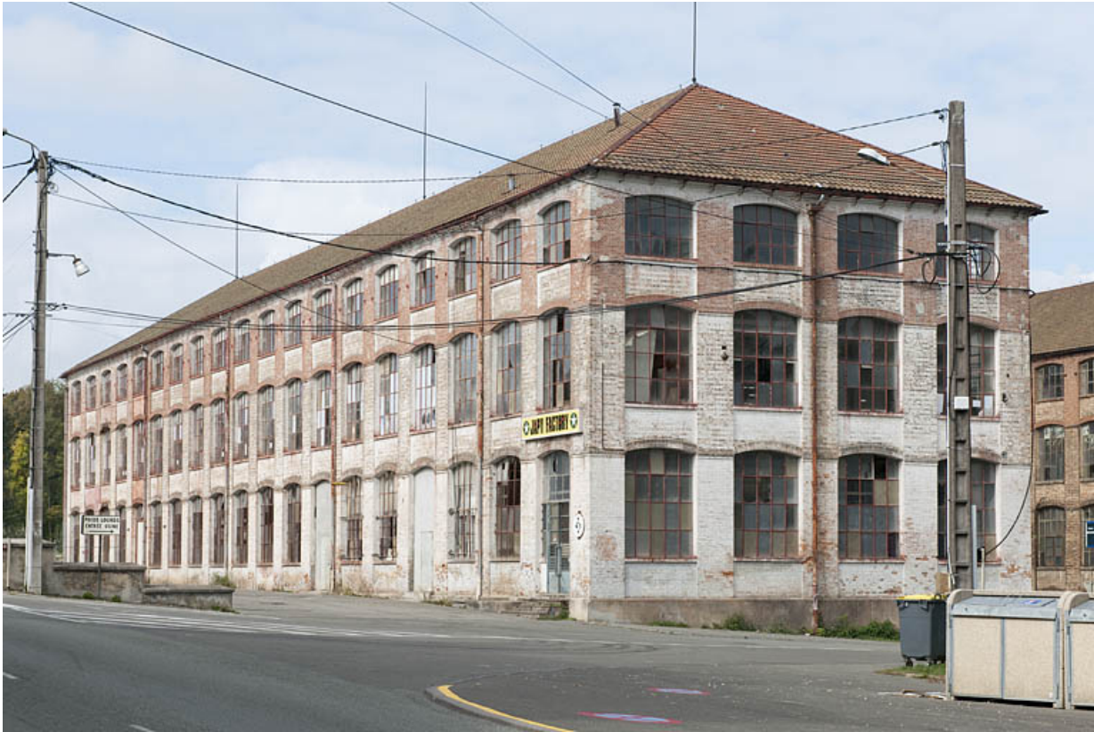
Vue d'ensemble rapprochée depuis le sud-est.
