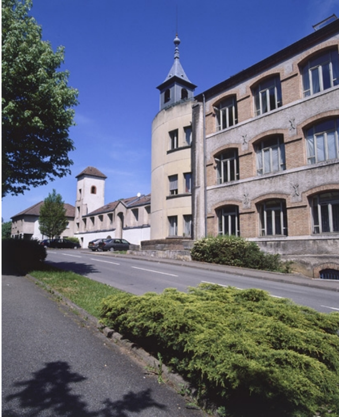
Façades sud depuis la rue Frédéric Japy.
