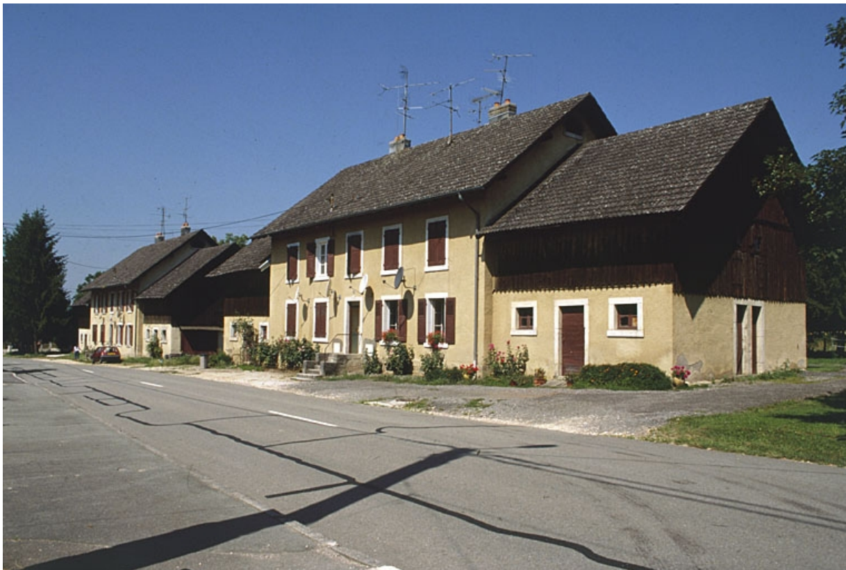
Logements collectifs route de Boron.
