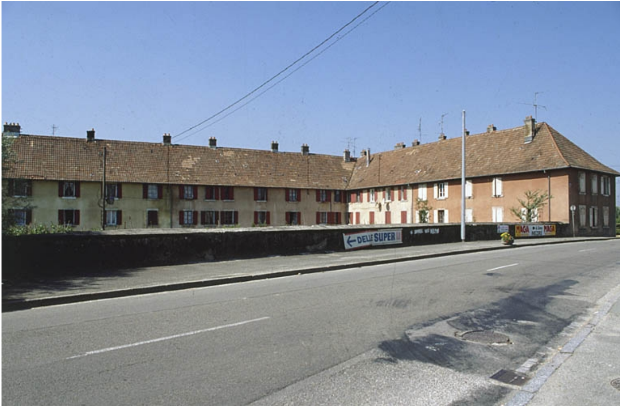
Logement ouvrier dit la Caserne depuis l'est.
