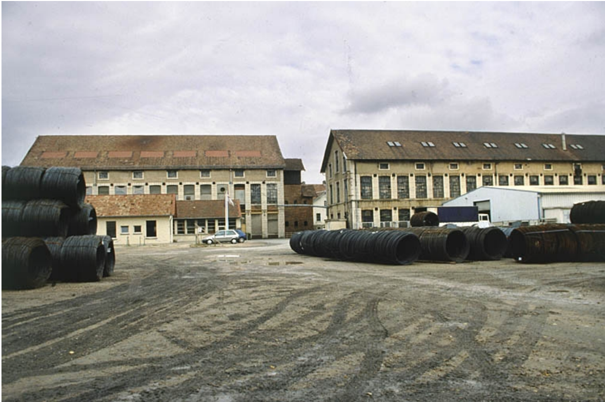
Façades est des ateliers de fabrication.
