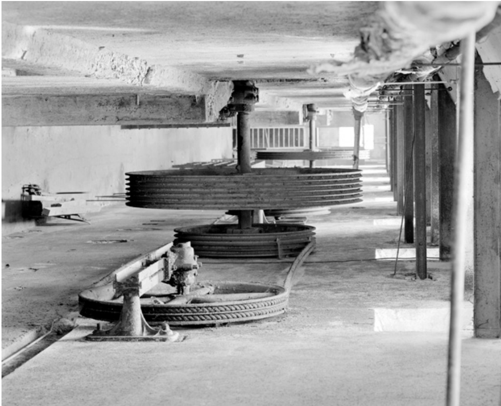
Poules de transmission dans le couloir des câbles.
