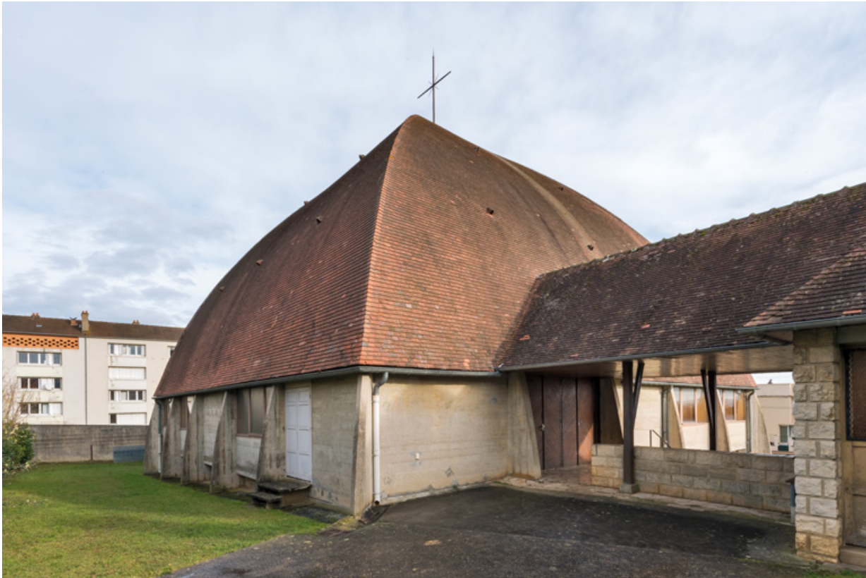
Eglise. Vue de trois quarts depuis l'est.
