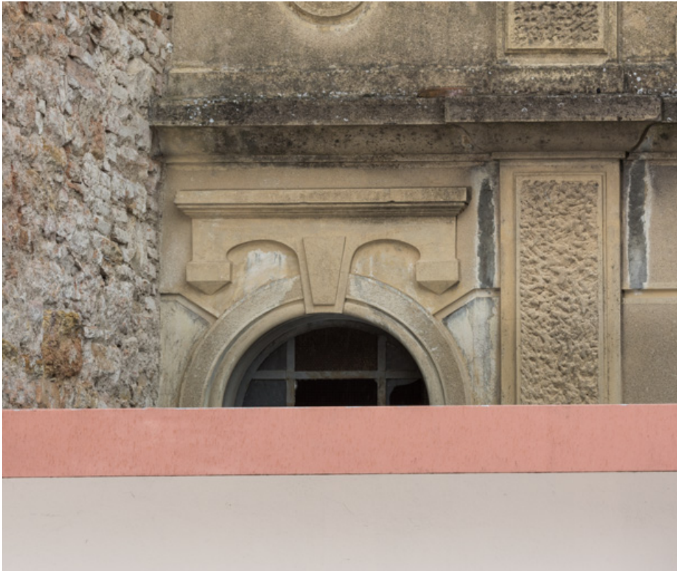
Façade antérieure : décor surmontant une fenêtre.
