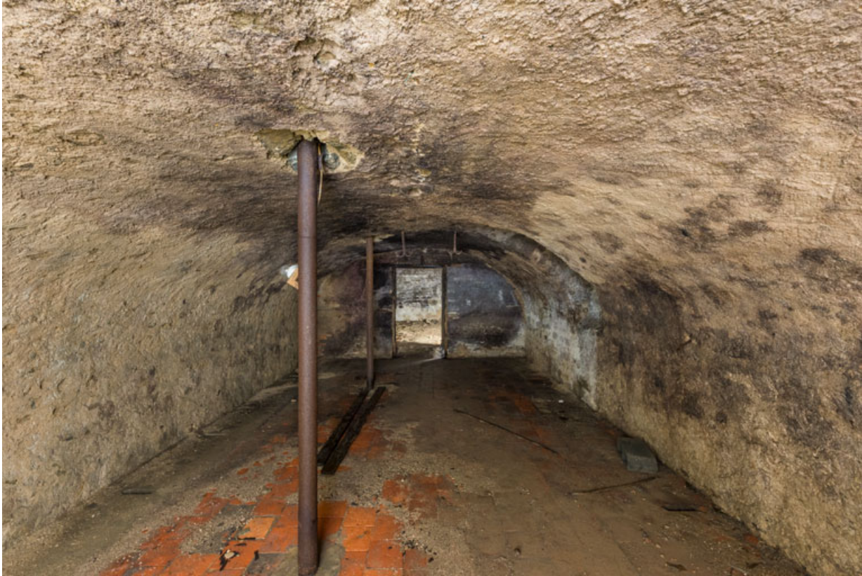
Cave voûtée sous la salle.
