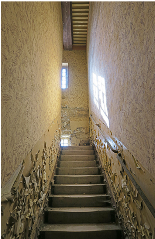
Première volée de l'escalier nord des prisonniers.
