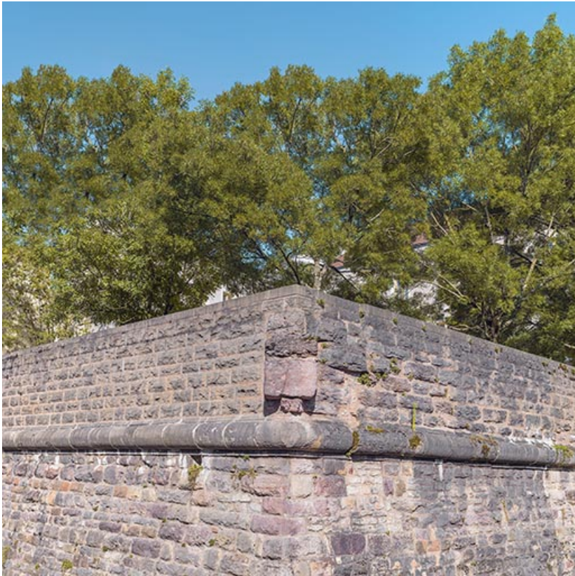
Détail de la maçonnerie.
