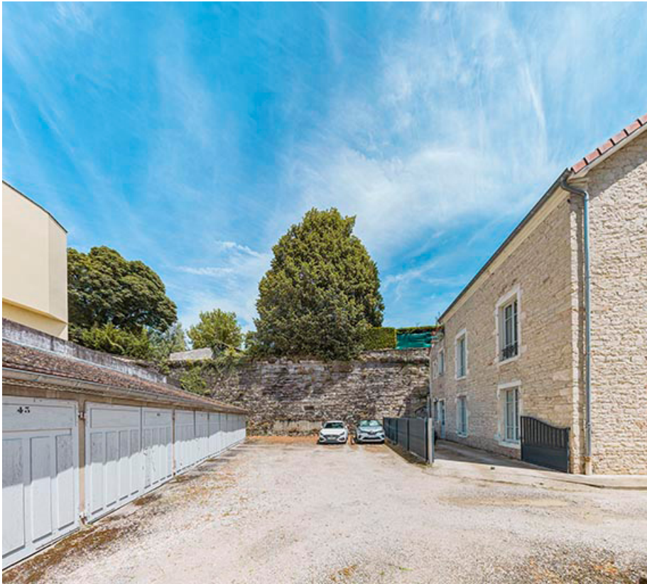
Portion du bastion Saint-Paul.
