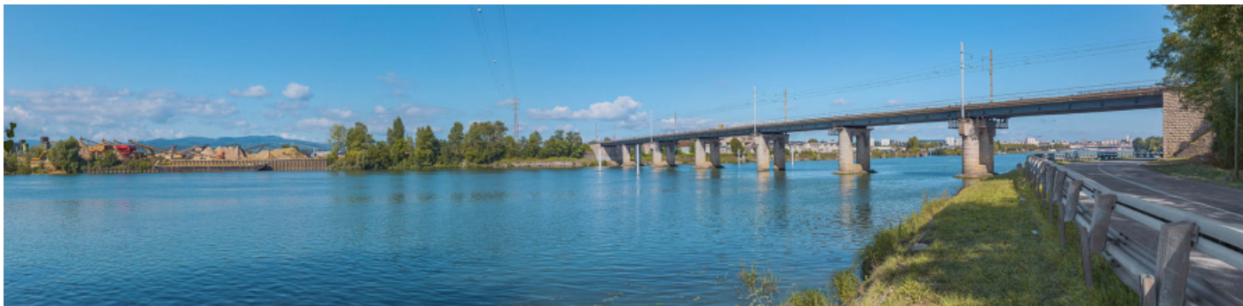
Le pont vu d'aval, rive gauche.
