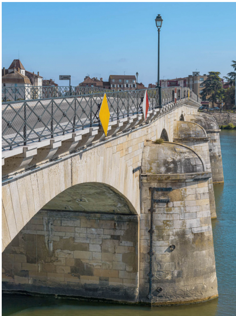
Détail des arrière-becs du pont.
