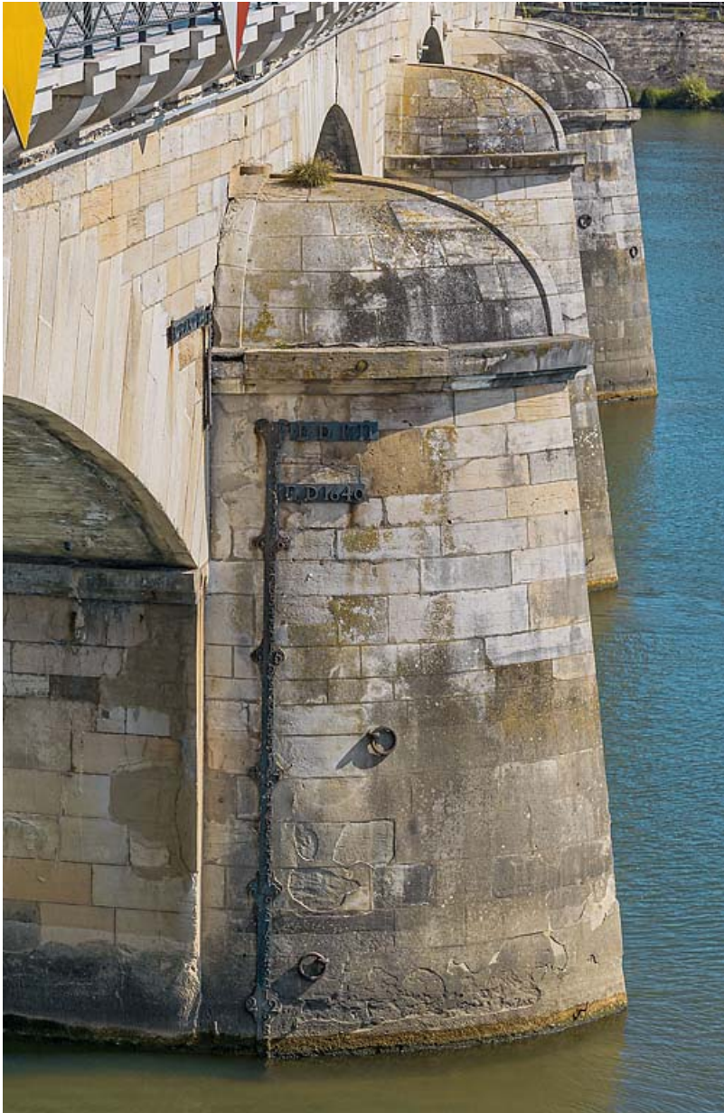
Détail des arrière-becs du pont et de l'échelle de crue.
