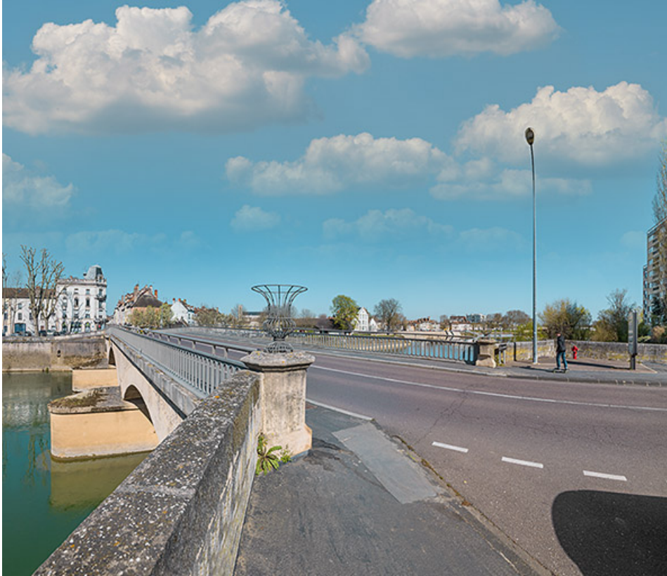
Vue d'ensemble du pont depuis la chaussée.
