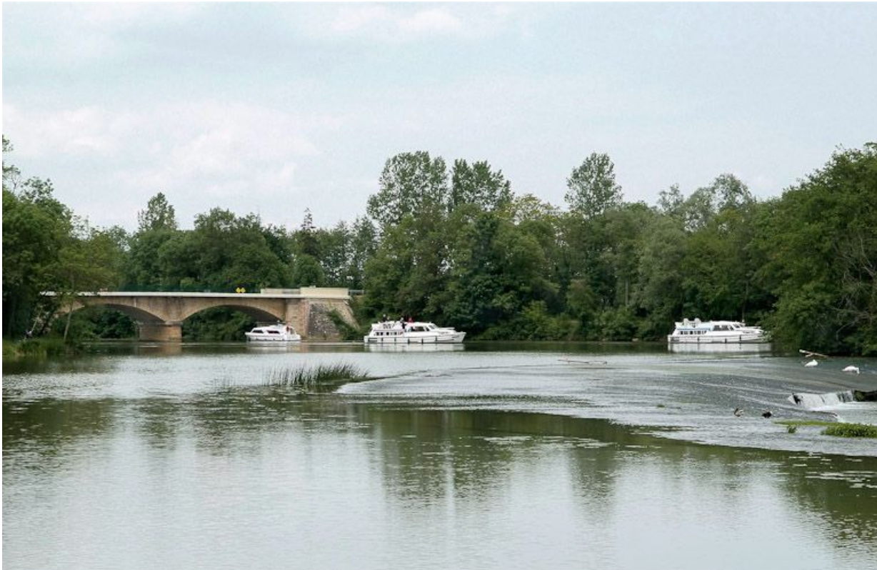
Le pont de Cuisery, vu d'aval.
