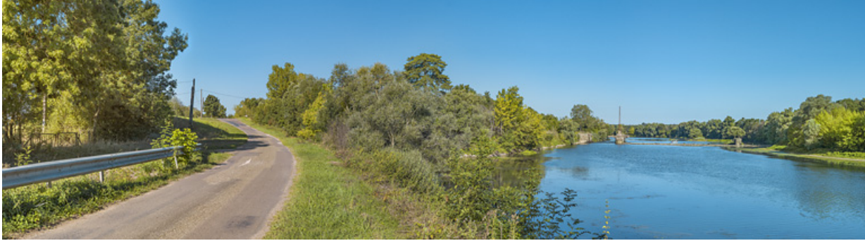
Vue d'ensemble du site du barrage en 2019.
