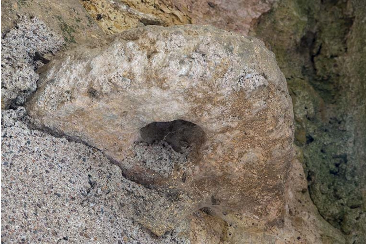
Détail d'un remploi pris dans la maçonnerie.
