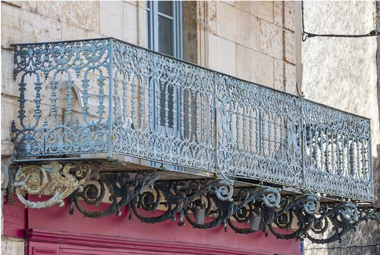
Le balcon du premier étage.
