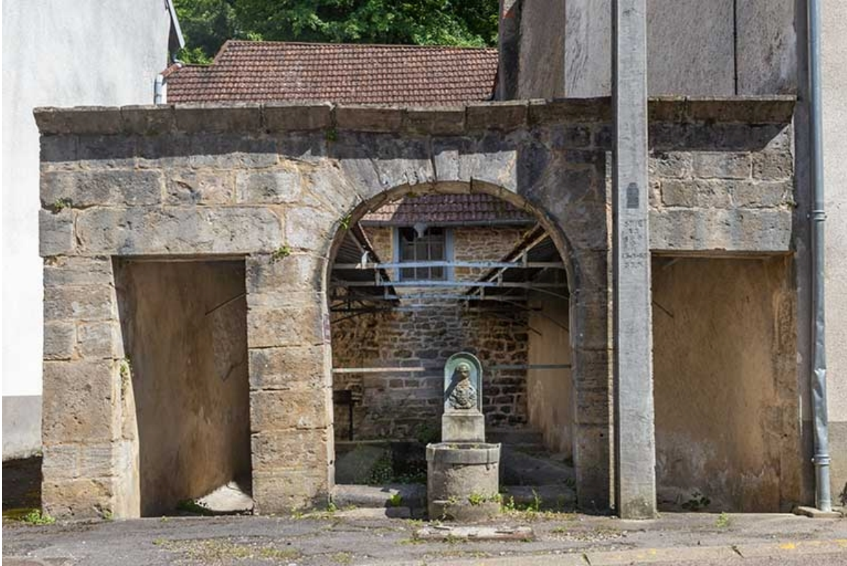
Face antérieure de la fontaine-lavoir.
