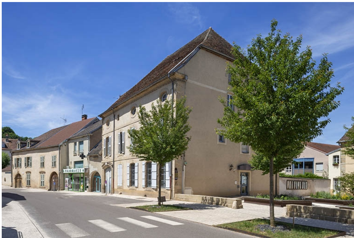
Le bâtiment de trois quarts droite.
